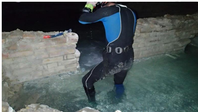
Foto 8 – Il muro di contenimento che dà origine al laghetto (sulla destra è visibile la tubazione di by-pass)
