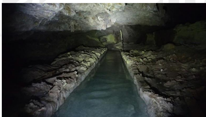
Foto 6 – Condotta interna di deflusso delle acque
