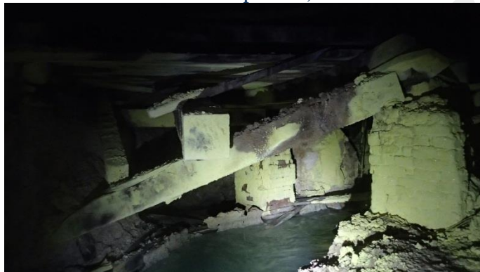
Foto 5 – Crollo di una parte del pontile
