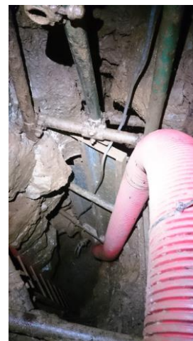
La pompa dell'aria per la bonifica della CO 2 (sx) ed i lavori per la messa in sicurezza (dx) nella Grotta Luftloch
