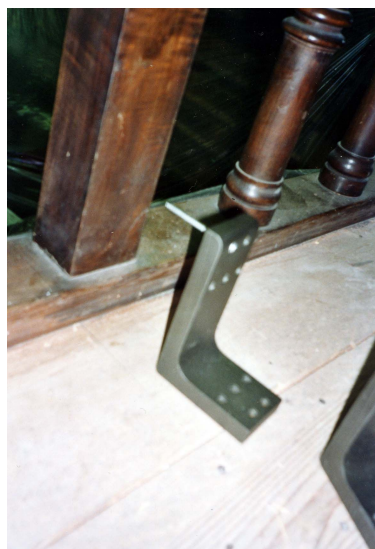
Particolare della squadretta metallica di rinforzo prima della messa in opera.
