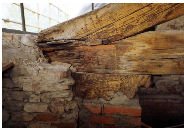
Vista della testata prima dell'intervento
