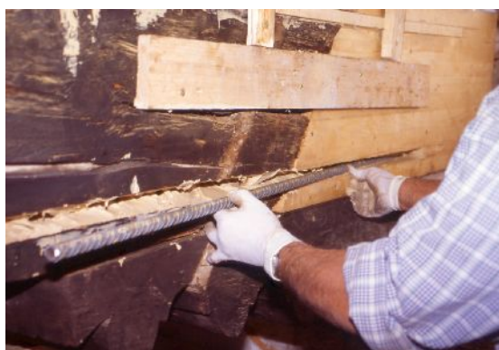
Inserimento della barra di acciaio.
