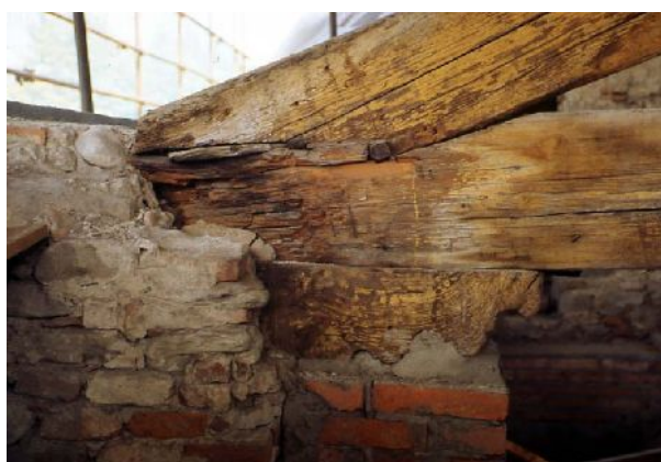
Vista della testata prima dell'intervento
