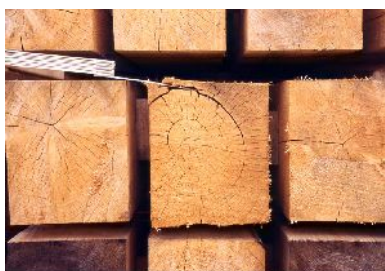
Trave di legno affetta da cipollatura.
