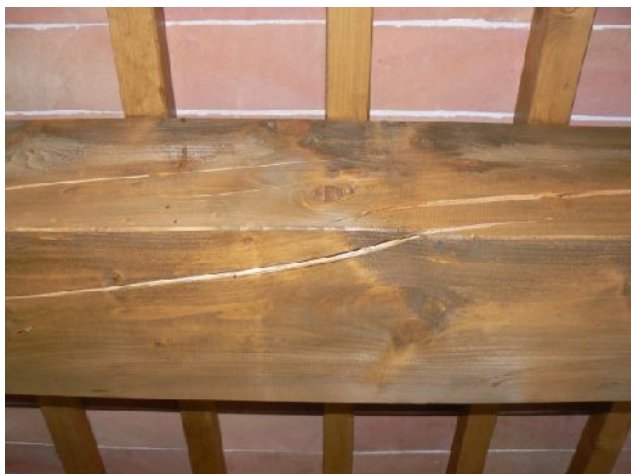
Foto 1.1: Le fessure da ritiro sono un fatto fisiologico che generalmente non deve destare preoccupazione, tuttavia in alcuni casi diventano strutturalmente intollerabili, ad esempio quando una trave è affetta da fessure su due facce e queste si incontrano dividendo in due la sezione oppure quando queste passano lo spigolo determinando una vera e propria rottura come nella foto.
