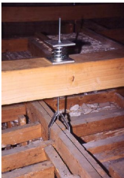
Particolare del pendino di collegamento fra le vecchie e le nuove strutture.
