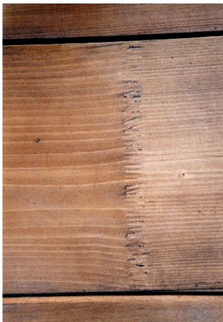
Esempi di cattiva realizzazione dei giunti a dita fra le tavole di una trave di legno lamellare incollato.
