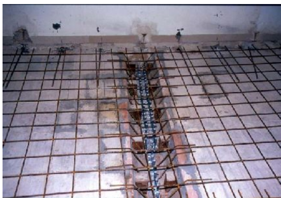
Solaio a doppia orditura con connettori tipo Tecnaria solo sulle travi principali, i connettori ai quarti estremi della luce sono disposti su due file; da notare le barre di ancoraggio a muro.
