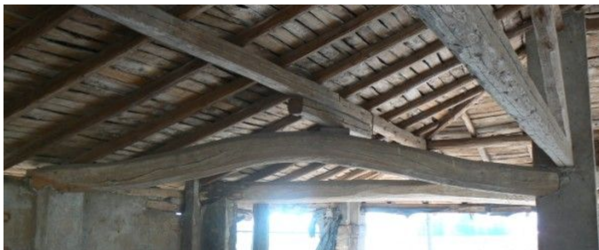
Foto 3.4: Particolare trave in legno massiccio naturalmente acuita ricavata da un tronco storto di natura.
