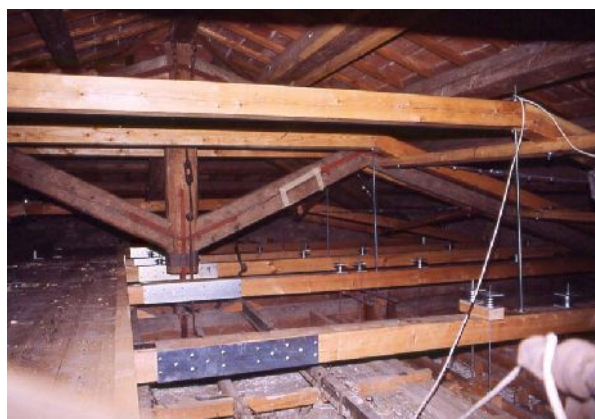
Vista dell'intervento; da notare sulla sinistra la passerella di ispezione realizzata sulle nuove capriate.
