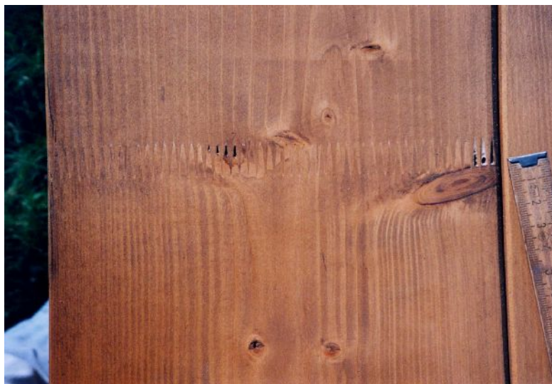
Esempi di cattiva realizzazione dei giunti a dita fra le tavole di una trave di legno lamellare incollato.
