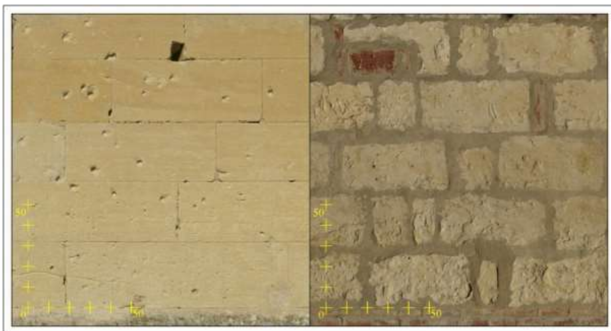
Fig. 5. Confronto tra le trame murarie della chiesa di San Giorgio a Casorzo (Asti), a sinistra (fase medievale) e della palazzina civile abitazione in località Roveto, Rosignano Monferrato (Alessandria), a destra (fase ottocentesca)
