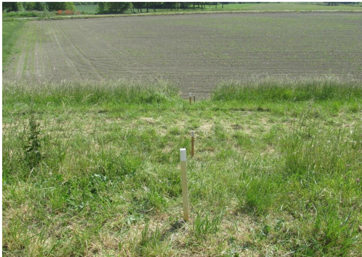
Foto 3.5 Picchettatura di una sezione trasversale.
