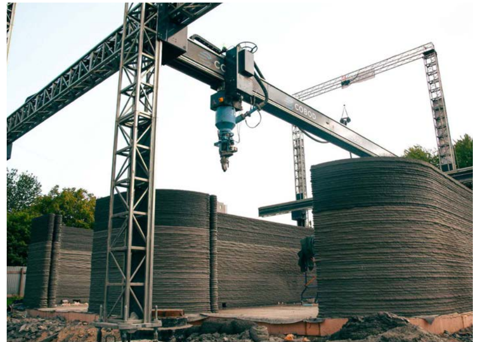
Immagini di cantiere. Fonte: Team4UA
