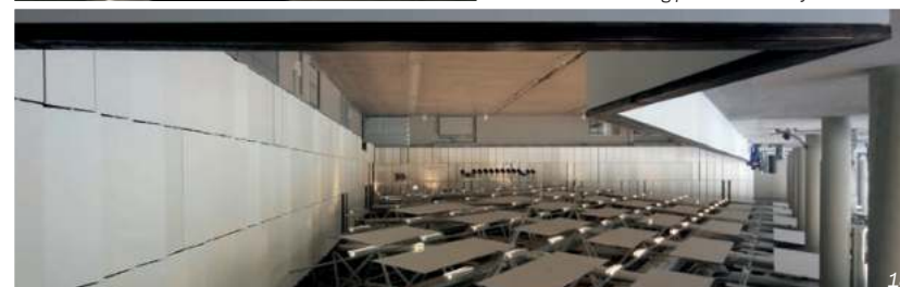
18_Foto del sistema di pannelli acustici posti come soffitto. Photo of the ceiling panel acoustic system.
