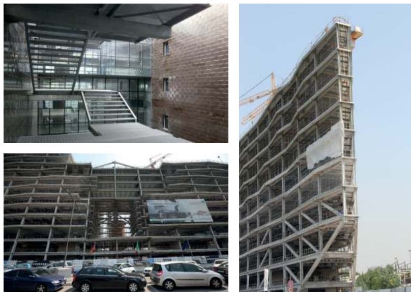
In alto e nella pagina seguente: Roma Tiburtina, nuova sede BNL. Viste esterne ed interne durante i lavori.
