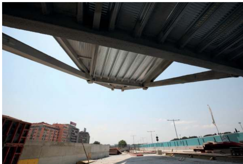
In alto e nelle pagine seguenti: Roma Tiburtina, nuova sede BNL. Viste esterne ed interne durante i lavori. Foto di F. Marzullo
