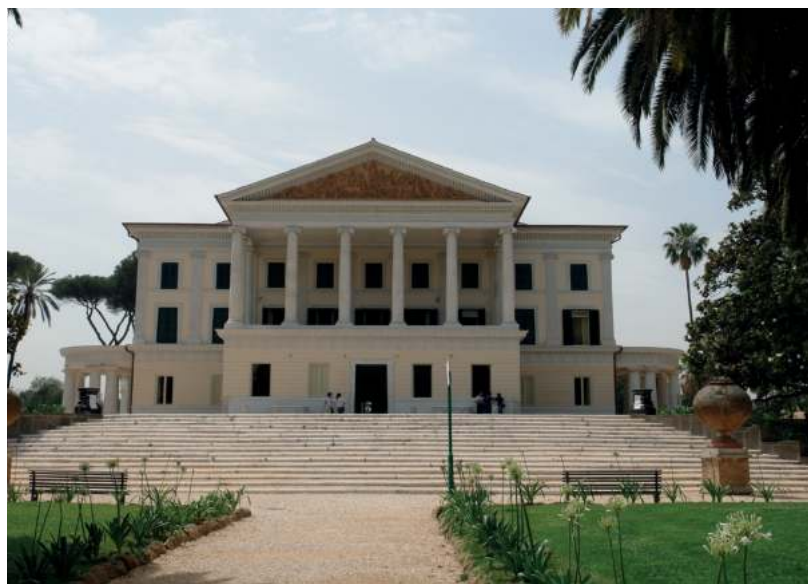
In alto e nella pagina seguente: Roma, Casino nobile di Villa Torlonia. Viste dell'esterno a conclusione dei lavori e dell'interno durante le attività. Foto di F.Marzullo
