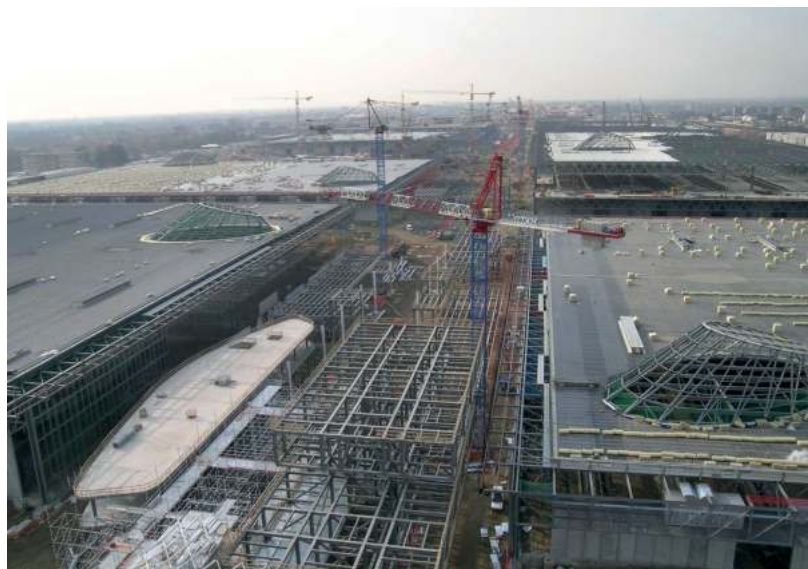
In alto e nelle pagine seguenti: Milano-Rho, Nuova Fiera. Viste delle aree di cantiere. Foto di F.Marzullo
