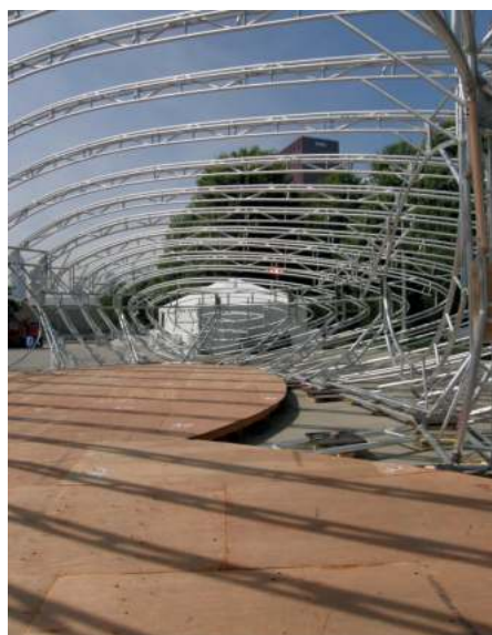
A sinistra e nella pagina a fianco: Zaha Hadid - Chicago, Barnham Pavilion Fasi di esecuzione ed installazione
