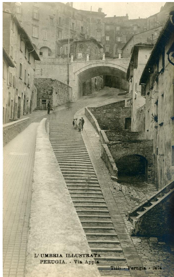
L'Umbria illustrata n. 2474 – Perugia, Via Appia. Tra le ultime della serie, questa cartolina risulta ripresa in controcampo della n. 1237 e comprende la lunga scalinata di Via Appia, il ponte della nuova via Cesare Battisti e, sulla sinistra, il tratto finale di via dell'acquedotto. Le linee prospettiche delle due vie convergono verso il gruppo di persone in posa presso l'arco. L'orientamento verticale del quadro e la corta focale enfatizzano la composizione.
