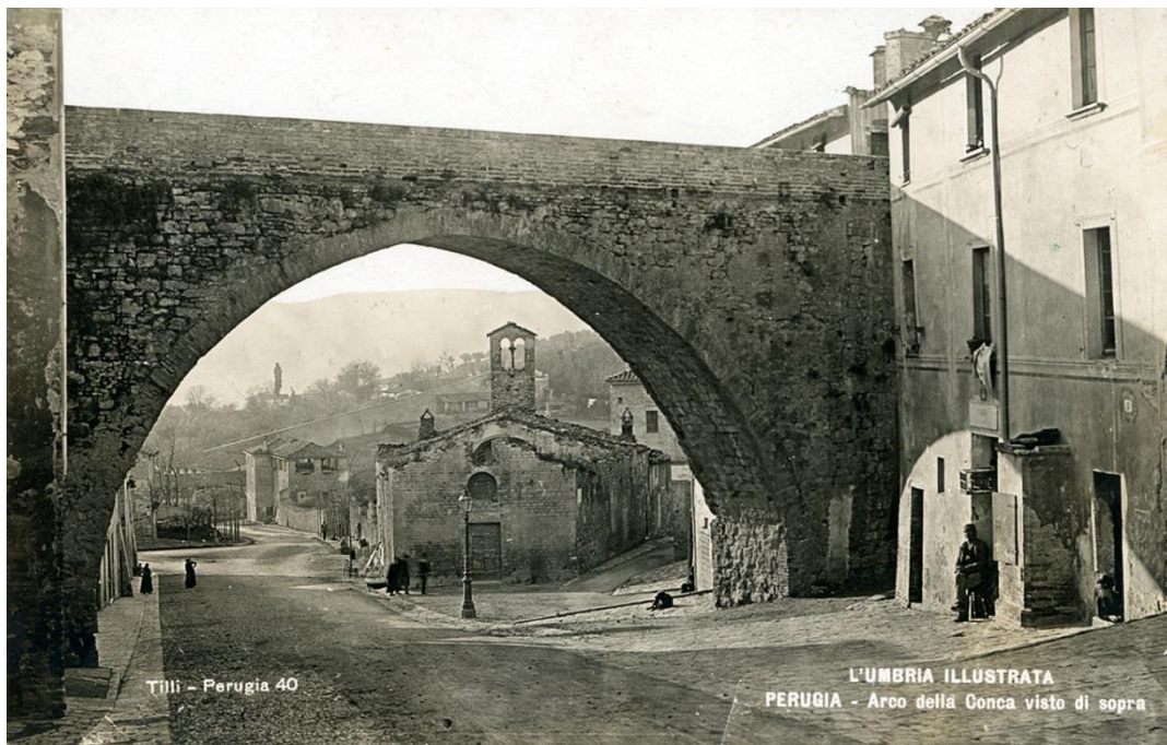
L'Umbria illustrata n. 40 – Perugia, L'arco della Conca visto di sopra. In questo suggestivo scorcio, l'arco dell'antico acquedotto, poi trasformato in un percorso sopraelevato, inquadra la chiesa di Santa Elisabetta in precarie condizioni dopo il crollo del tetto. Rispetto ad una analoga veduta Alinari, l'inquadratura di Tilli risulta più ampia, includendo anche gli edifici ai lati dell'arco.
