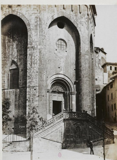
Fig. 5/b – 3410 - Esterno della chiesa di S. Ercolano in Perugia
