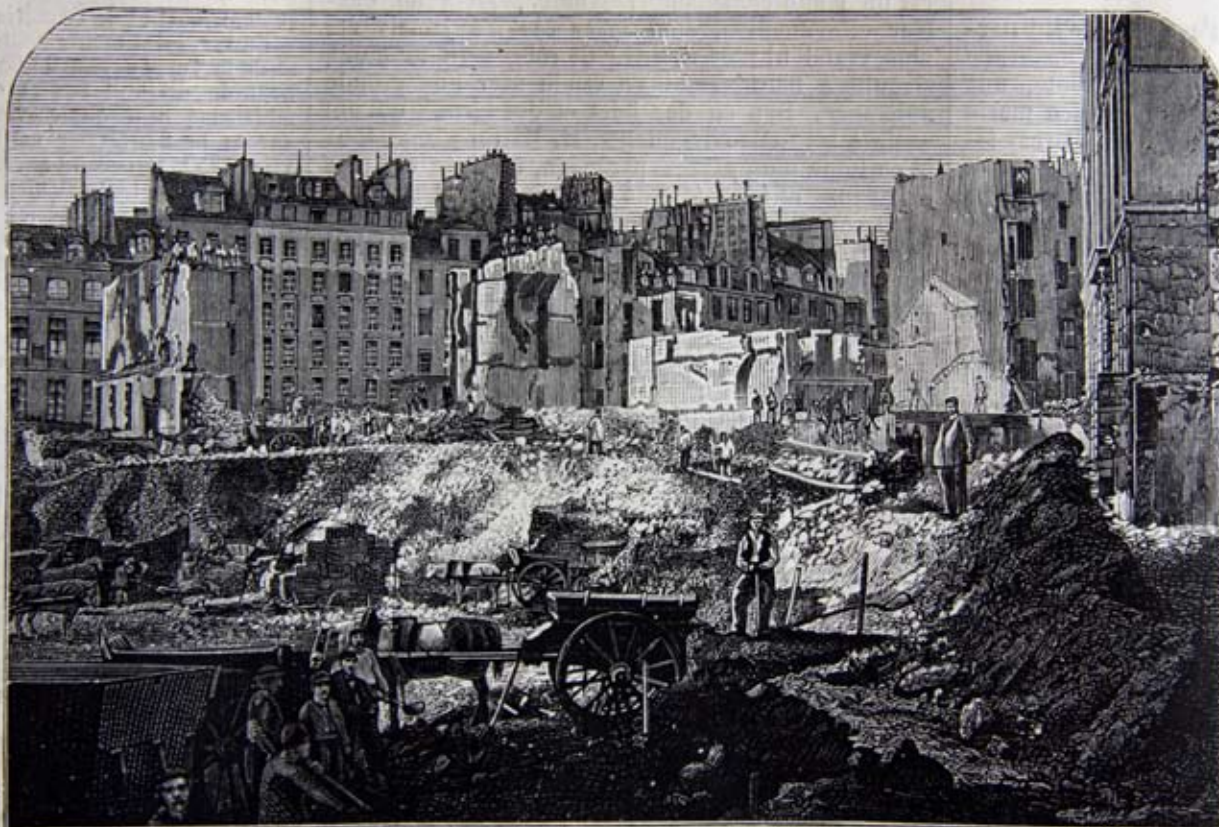
ASPECT DES DÉMOLITIONS ENTRE LA RUE MOLIERE ET LA RUE D'ARGENTEUIL.
