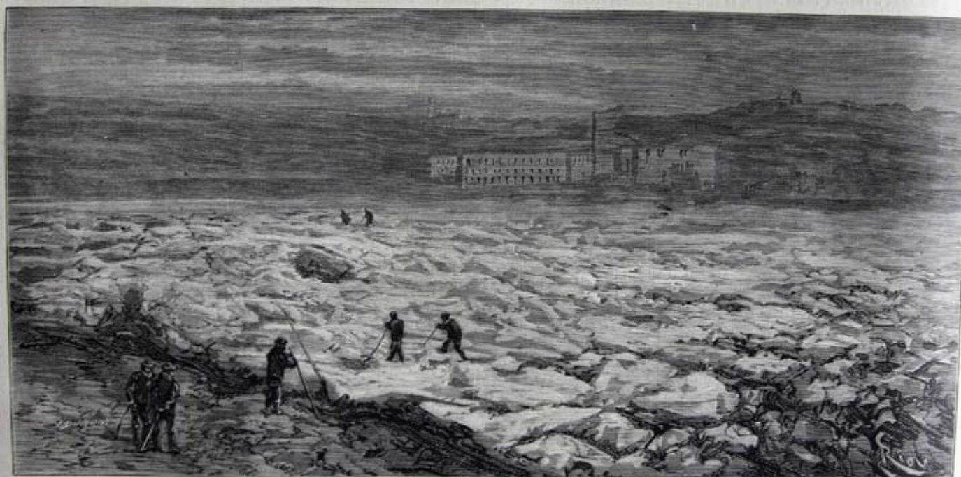
LA BAQUISE DE LA SAÔNE A LYON, EN AMONT DU FAUBOURG DE VAISE. — D'après une photographie de M. Bernoud.
