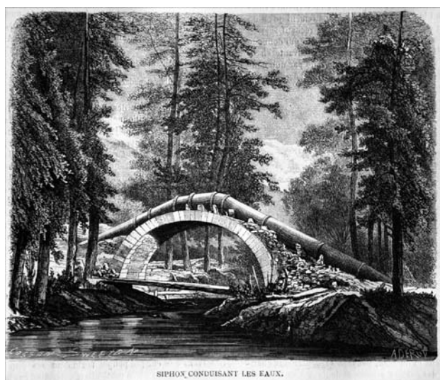
SYPHON CONDUISANT LES EAUX.
