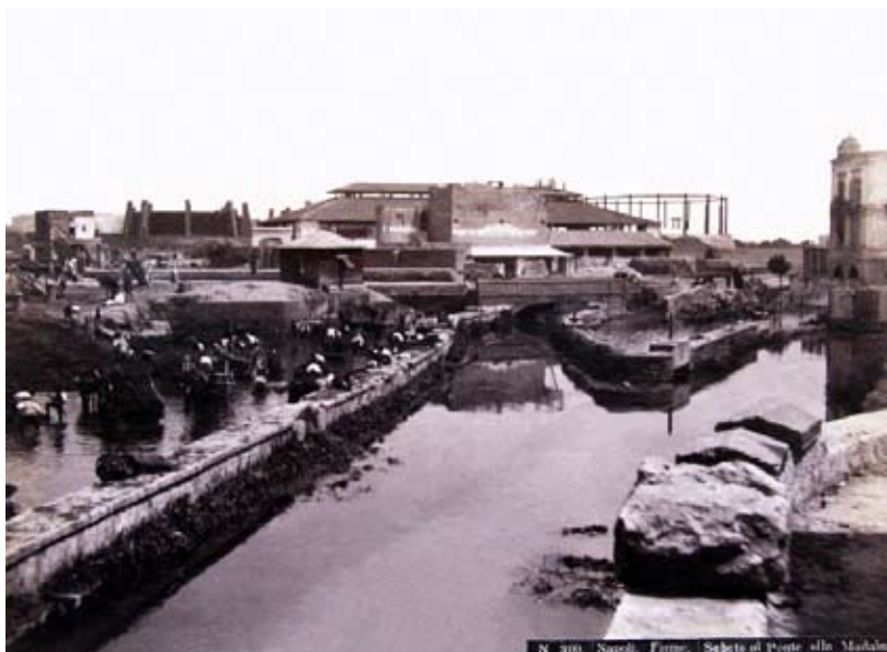
N.° 309. Napoli. Fiume. Sebeto al Ponte alla Maddalena
