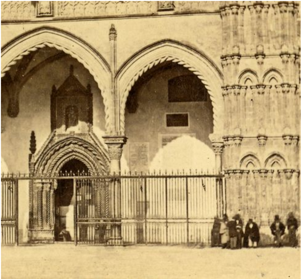
N°3 - Portique du Dôme, n° 1 Dettaglio
