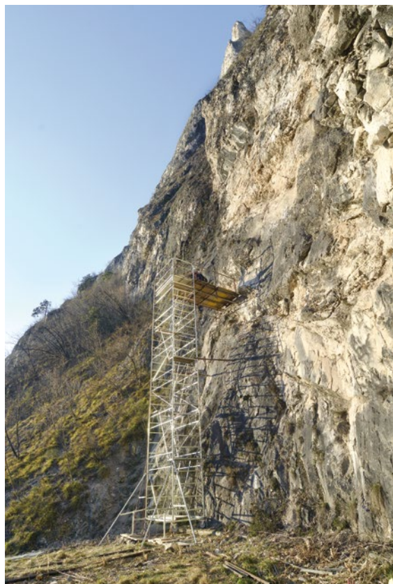
Fig. 3 – Nogarole di Mezzolombardo (Trento). Localizzazione del riparo 4 con l'impalcatura utilizzata per effettuare il recupero della sepoltura (Archivio Ufficio beni archeologici – PAT; foto Giovanni Cavulli)
