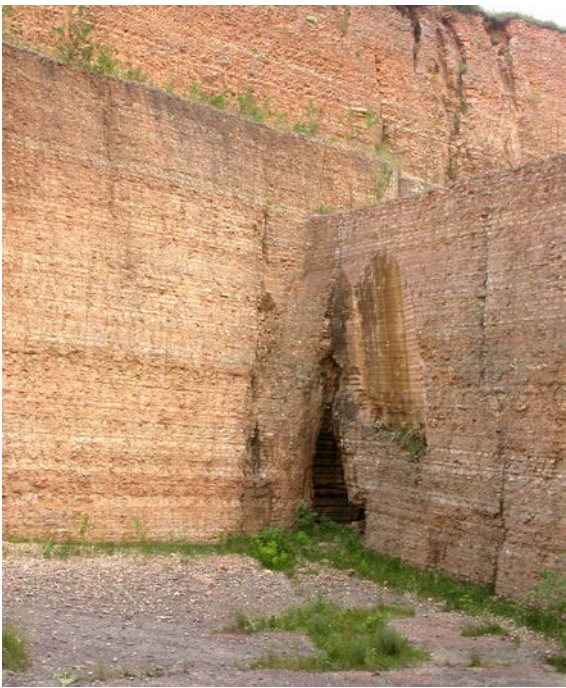
Fig. 25 – L’ampio condotto carsico intercettato dall’avanzamento della coltivazione del lastame entro cui il 3 luglio 2013 è stato eseguito il test con Tinopal (foto R. Zorzin)
