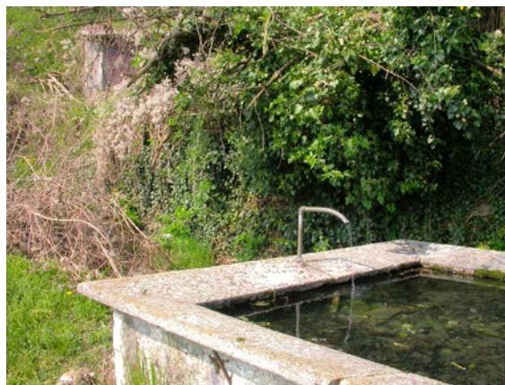
Fig. 33 – L'opera di presa della Sorgente Grota con il vicino lavatoio (foto R. Zorzin)
