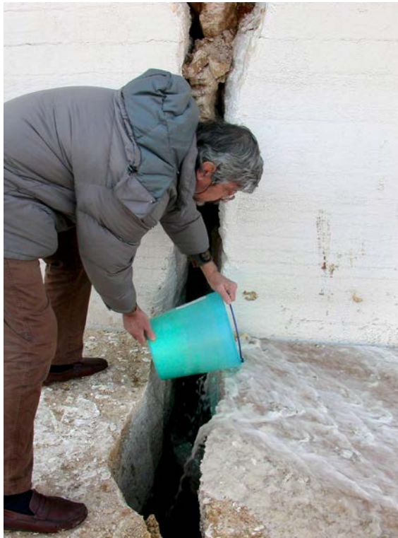
Fig. 21 – Tracciamento con Tinopal all'interno di un'ampia frattura incarsita dal cui fondo si percepiva un chiaro rumore di acqua fluente (foto A. Zorzin)
