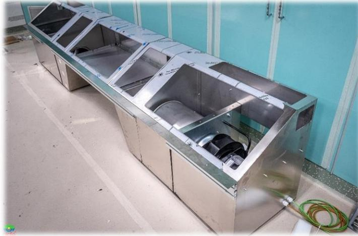
I motori a portata variabile dimensionati in base alle dimensioni del teatro operatorio sono controllati e visualizzati dal sistema **NICFA®** Controller per garantire un funzionamento costante al variare delle grandezze misurate dalle **NICFA®** Probe.
