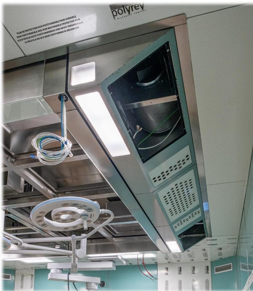
La particolare conformazione dell'unità di ricircolo attraverso l'inclinazione di 30° consente **di riprendere l'aria di ricircolo senza creare interferenze al flusso laminare.**
