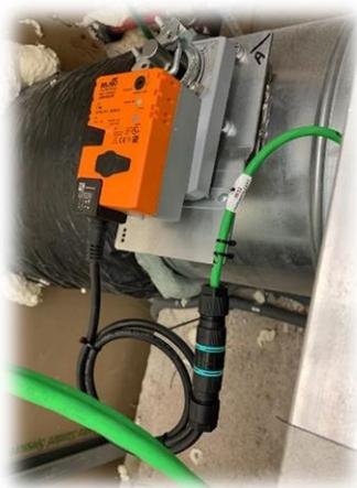
**Due serrande** ad alta velocità di commutazione (rif. 3 e 4), che consentono il ricircolo dell'aria all'interno della stanza (tramite il filtro interno rif. 5) o nel corridoio (tramite il filtro esterno numero 5).
