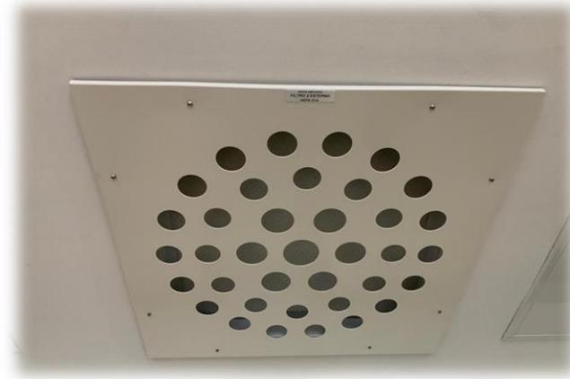
**Diffusori** dotati di filtri assoluti H14 ad alta portata, in modo che sia l'aria di ricircolo che la lama d'aria non veicolano contaminanti
