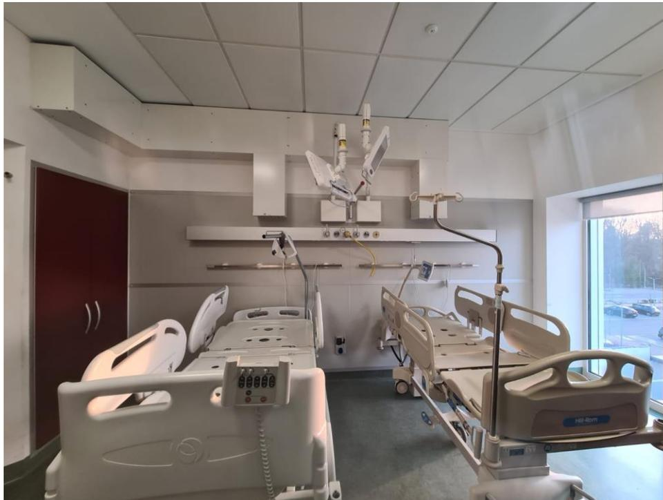
**Prese d'aria** (rif. 9), sopra i letti dei pazienti, sono dotate di filtro G4, per ridurre il rischio di intasamento dei filtri H14 con contaminanti di grosse dimensioni (es. polvere).
