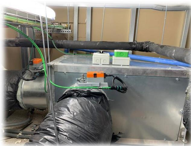
**Box Ventilatore EVS** (Rif. 2) dim. 1000x580x580mm completo di silenziatori, differenziale di pressione e sezionatore motore con due canali di uscita installato nel controsoffitto del bagno della stanza.
