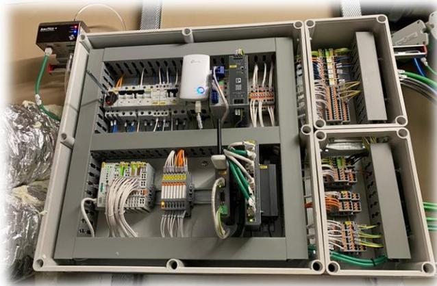
Controllo **NodeIO** con software di gestione integrato, sensore di controllo apertura porta, controllo velocità ventilatore, differenziali di pressione filtri, modulo di **teleassistenza** o **VPN** fornita dalla struttura.
