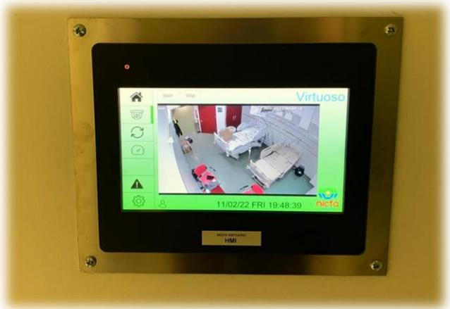
**Touch HMI**, per visualizzare i parametri e abilitare il controllo/impostazione del sistema dopo aver inserito un codice di sicurezza (differenziazione del background display in base al modo di utilizzo).
