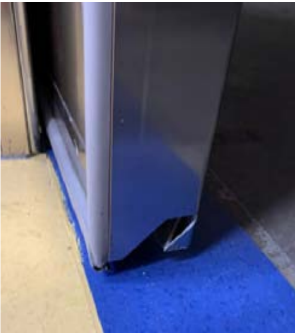
Hermetic gasket for automatic sliding door
