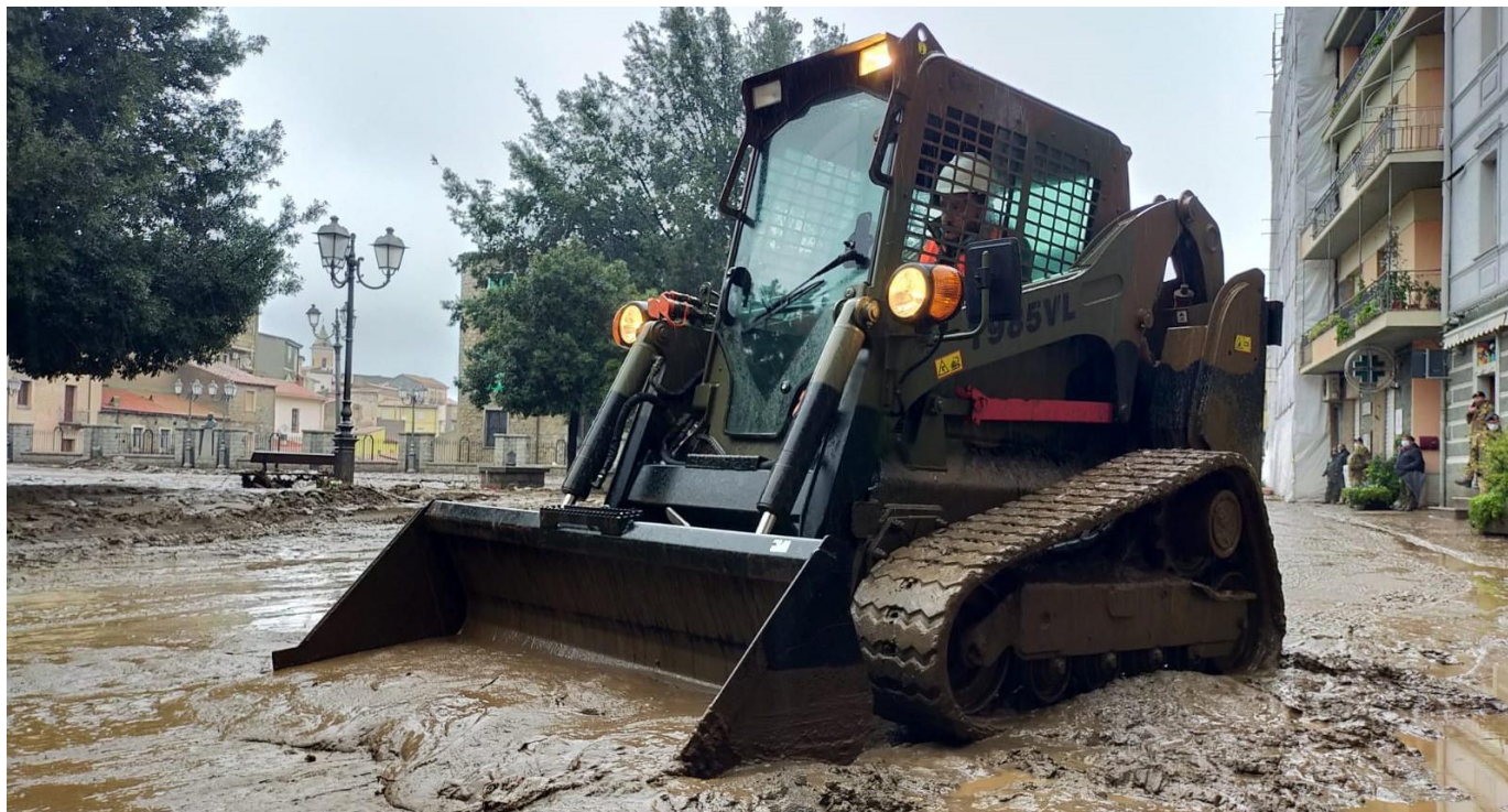
Skid Loader T985VL al lavoro in Piazza Asproni a Bitti (NU)
