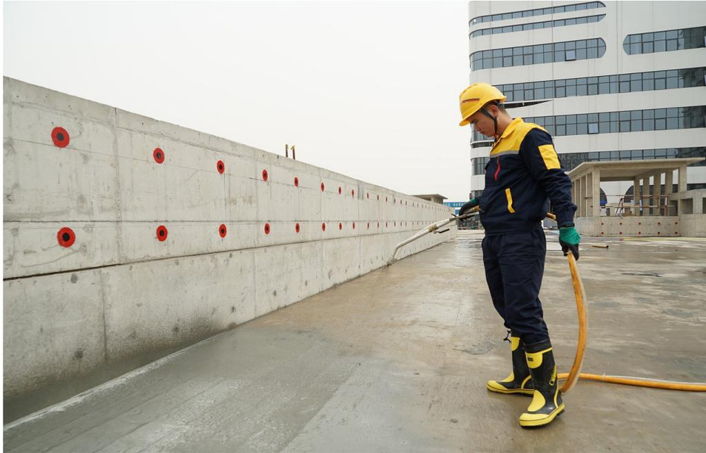
L'impermeabilizzazione mediante spruzzo di poliurea è una tecnica avanzata utilizzata per creare una barriera resistente all'acqua su diverse superfici. La poliurea è un polimero elastomerico che, una volta applicato, crea un rivestimento continuo, senza giunture, caratterizzato da un'alta resistenza chimica e meccanica.
