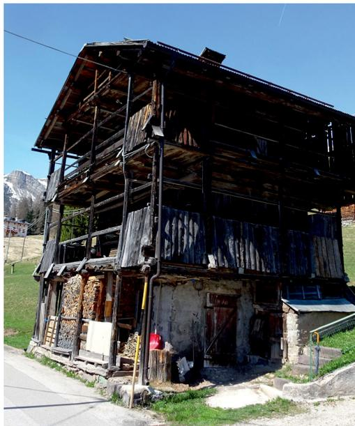
La costruzione a telaio (*kolondel*), vede la posa di montanti in legno, distanziati fra di loro di alcuni metri, che sono uniti fra di loro orizzontalmente da travi interpiano e controventati da travetti disposti secondo una data inclinazione.
