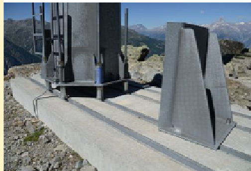
Costruire sul permafrost: supporto galleggiante (Foto: Marcia Phillips / SLF)
