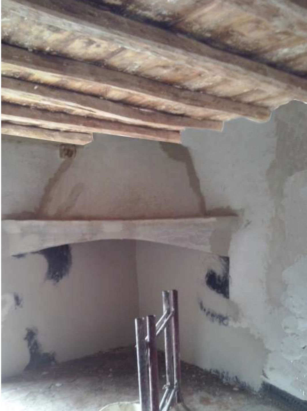
Solaio in legno a pulizia ultimata e restauro del camino.
