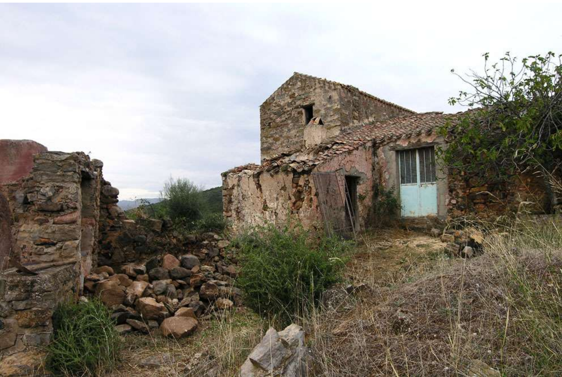
Inizio della pulizia dei ruderi delle murature della corte.
