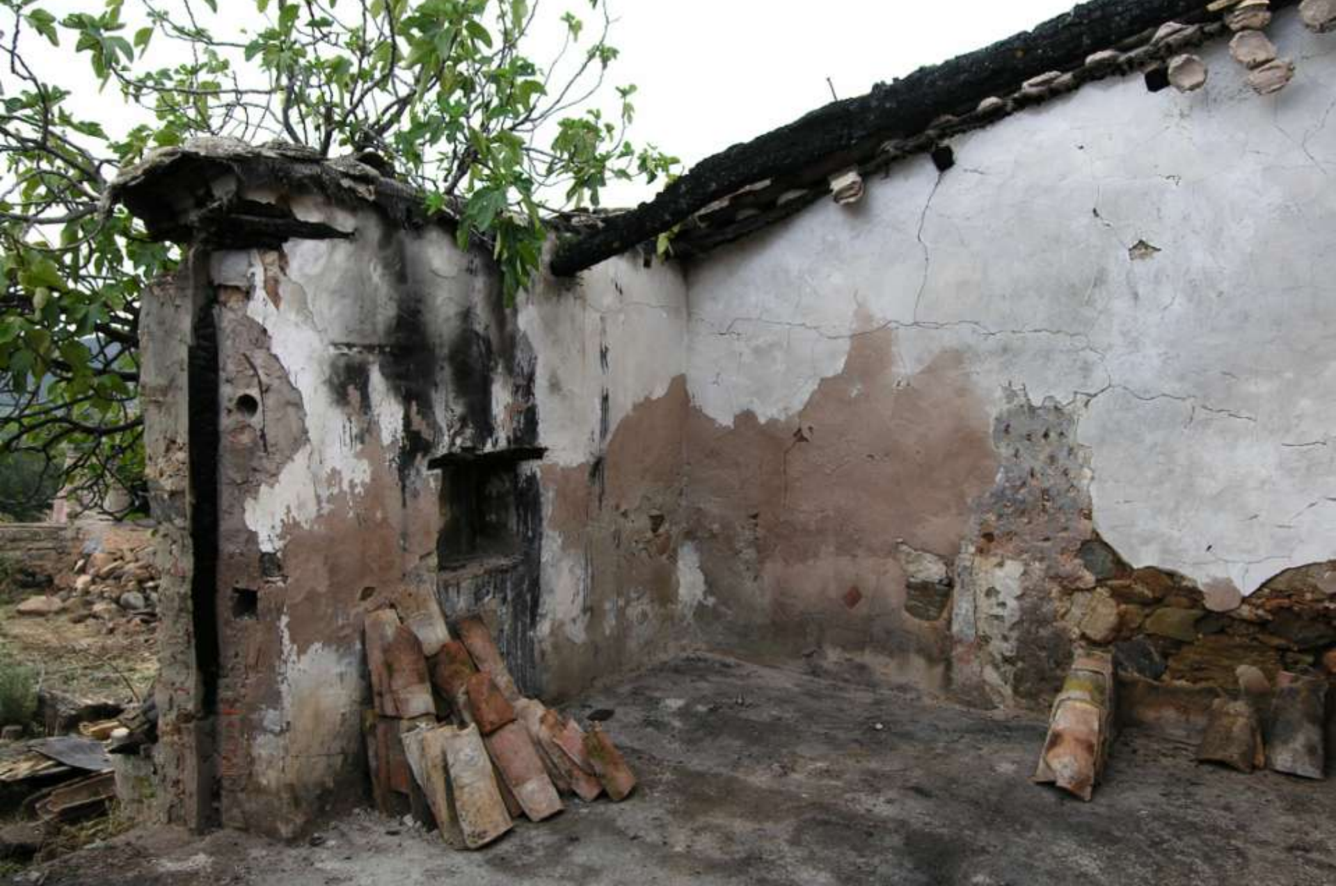
Pulizia dalle macerie e recupero dei materiali.
