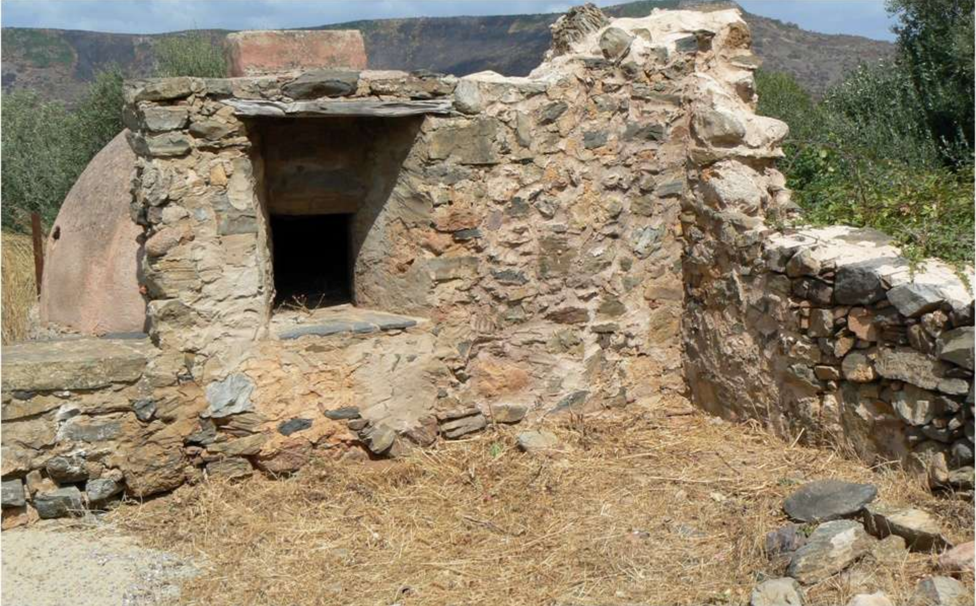
Riconsolidamento delle murature con malte a base di calce.
