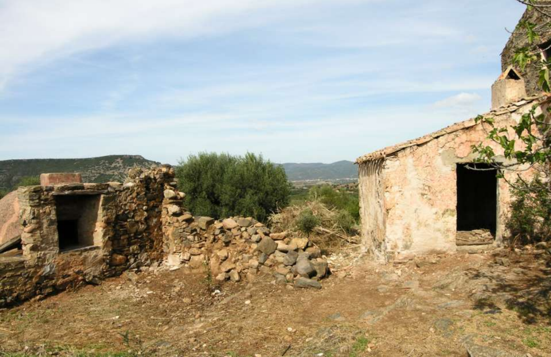
Prima fase del recupero. Ricucitura delle murature della corte.
