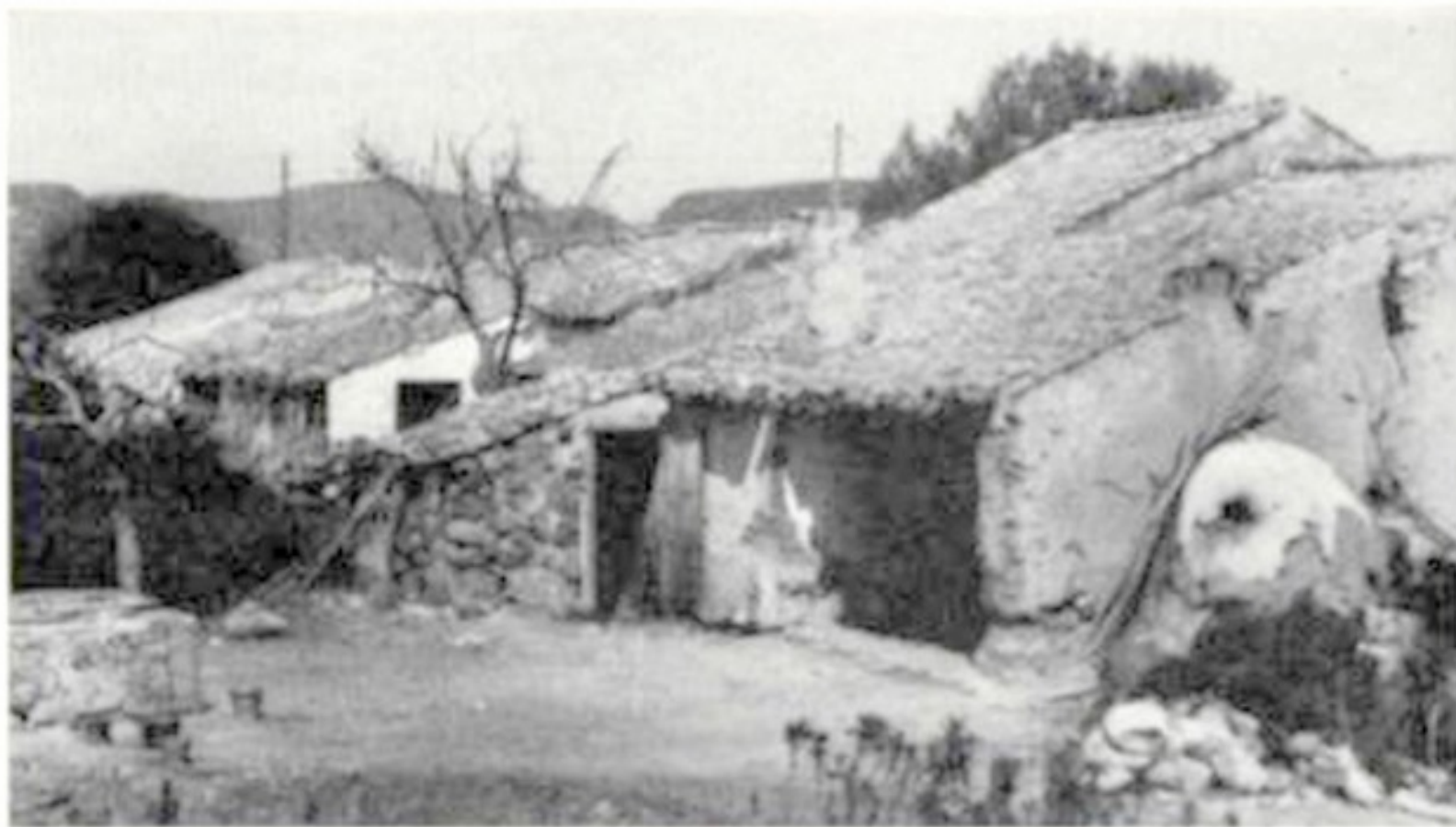
Fig. 16 - I sorprendenti effetti architettonici di queste costruzioni sulcitane derivano in gran parte da un felice e disuguale uso del tetto a due falde, condotto a copertura di logge e di piccoli ambienti accessori, dove il camino segnala la presenza dell'unità familiare.
