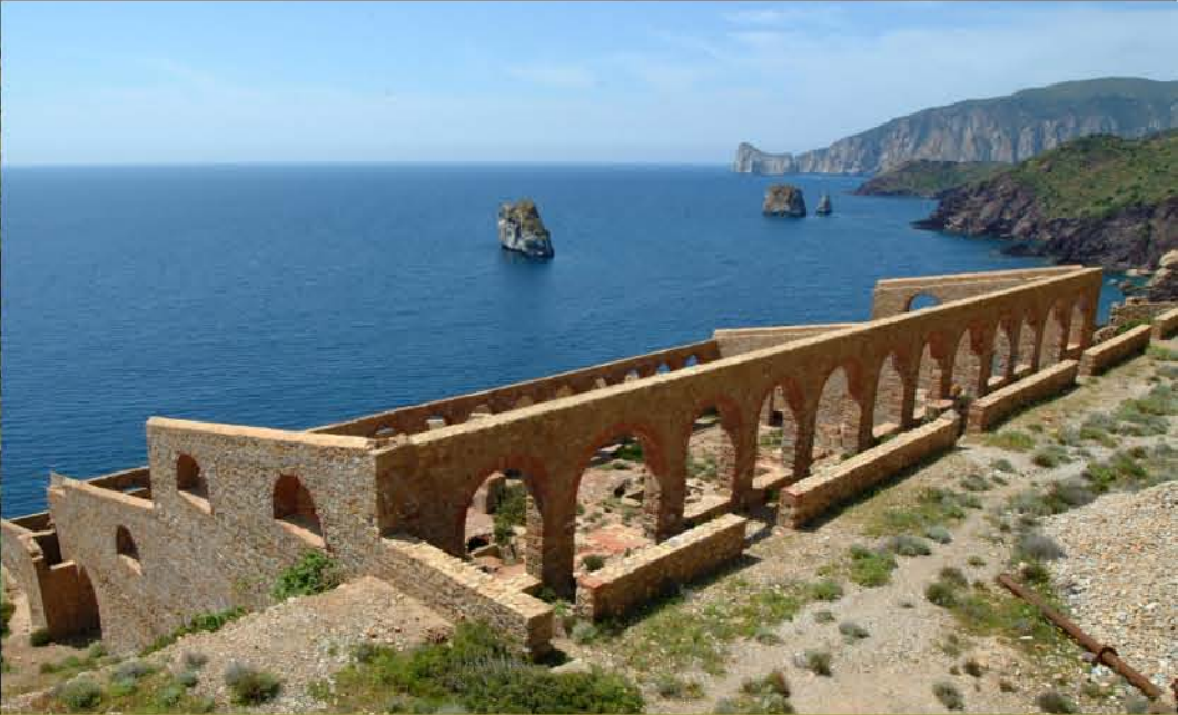
Il sistema dell'insediamento produttivo minerario della laveria di Nebida, localizzato strategicamente sul versante costiero
