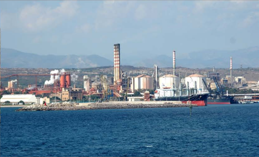
L'insediamento industriale di Portovesme
