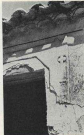
Fig. 19 - Porta d'ingresso di un'abitazione, con decorazioni rustiche. Da notare l'incorniciatura che nel ripetere motivi di mostre in legno assume quasi a dignità architettonica. Il maggiore oggetto a protezione del vano è ottenuto con un elaborato impiego di coppi.
