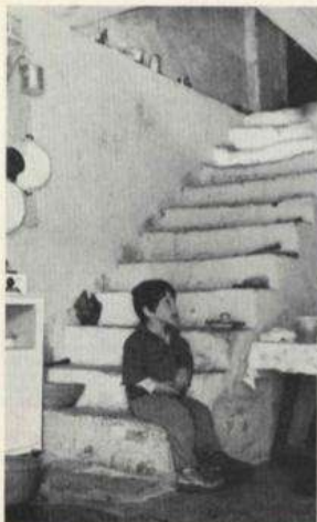
Fig. 15 - Scala di accesso al piano alto realizzata in muratura e senza ringhiera, di evidente ispirazione spagnola. I gradini sono spesso utilizzati come sedili o piani d'appoggio per utensili domestici.
