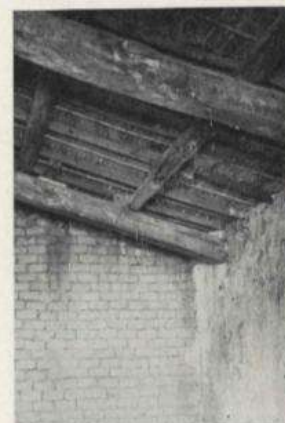
Fig. 20 - I materiali che ricorrono più frequentemente nelle costruzioni sono la pietra, i mattoni crudi e il legno delle coperture. I muri sono spesso intonacati in malta d'argilla o calce e in tal caso tingeggiati (Furiadroxio Is Langius).
