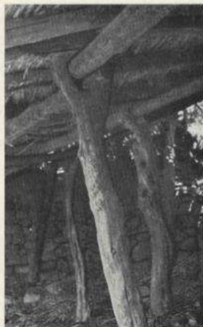
Fig. 23 - Diverse soluzioni strutturali nelle tettoie dei locali rustici destinati al ricovero del bestiame ( Furriadroxiu Chilau ).
