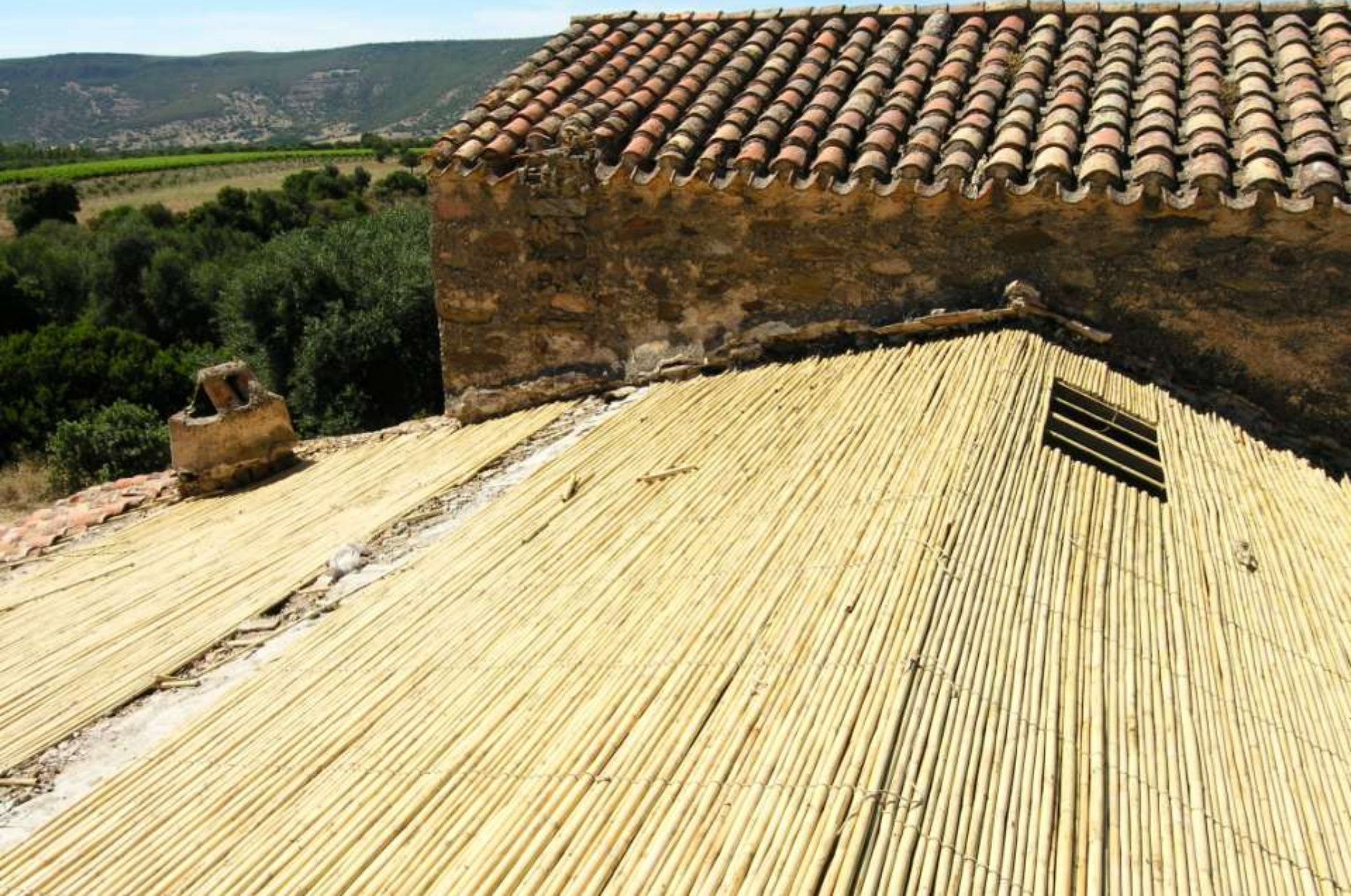
Ultimazione della posa delle canne di palude.
