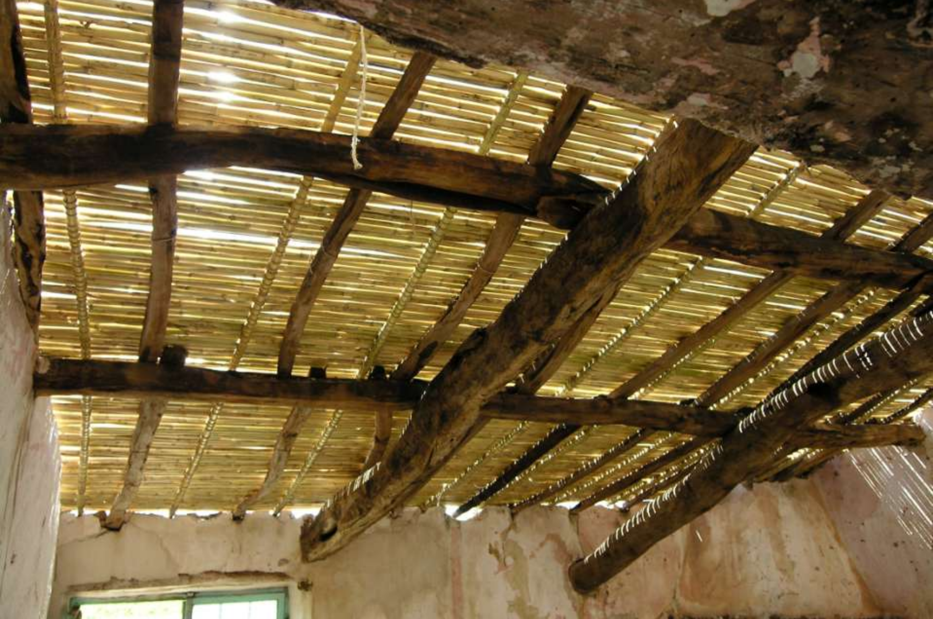
Le travi originali pulite e la stuoia in canne. Le canne maestre sono disposte tra un arcareccio e l'altro.
