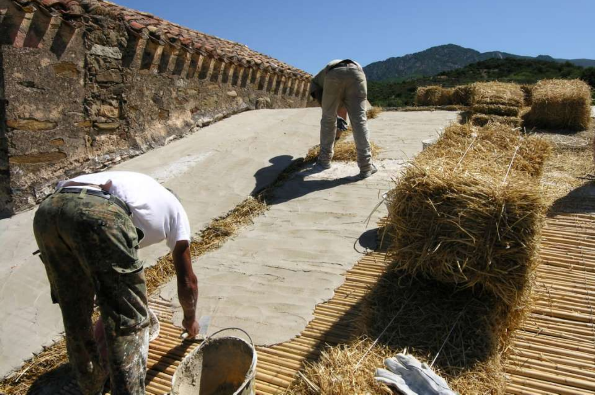
Messa in opera dell'isolamento in paglia.
