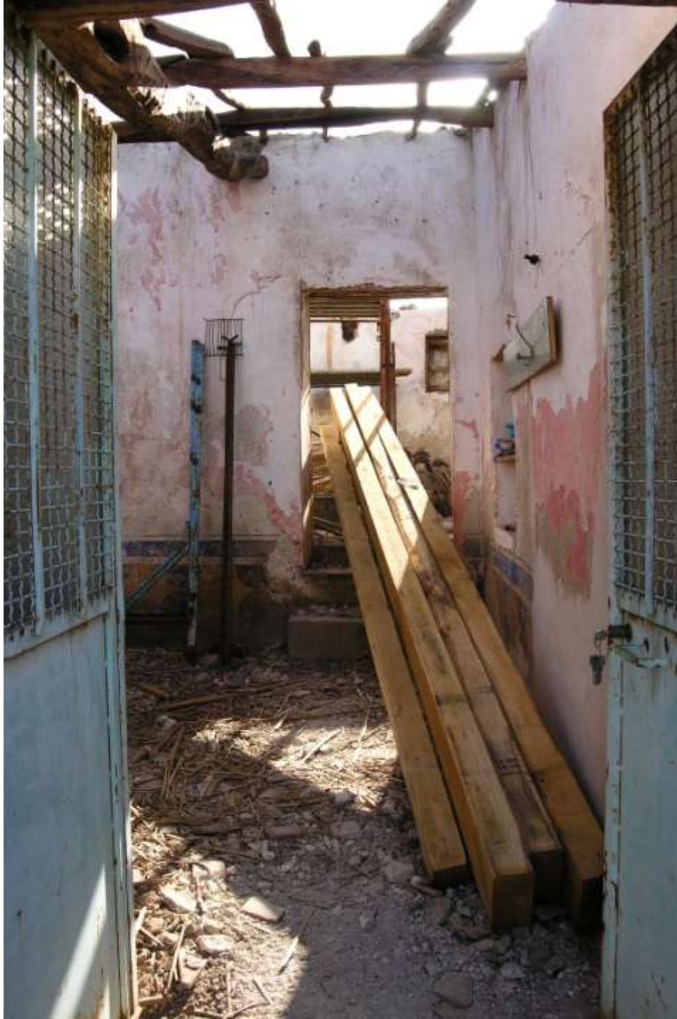
La messa in opera delle nuove travi della copertura.
