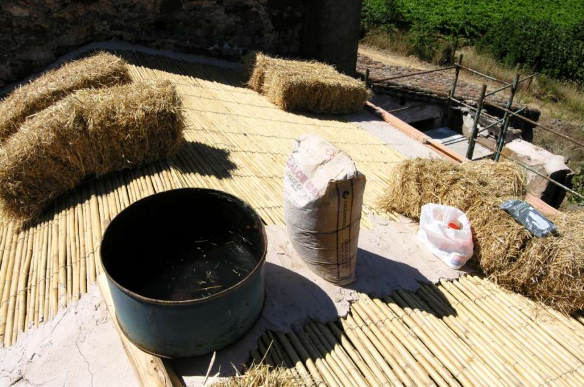
I materiali. Canne di palude, paglia, calce, acqua.
