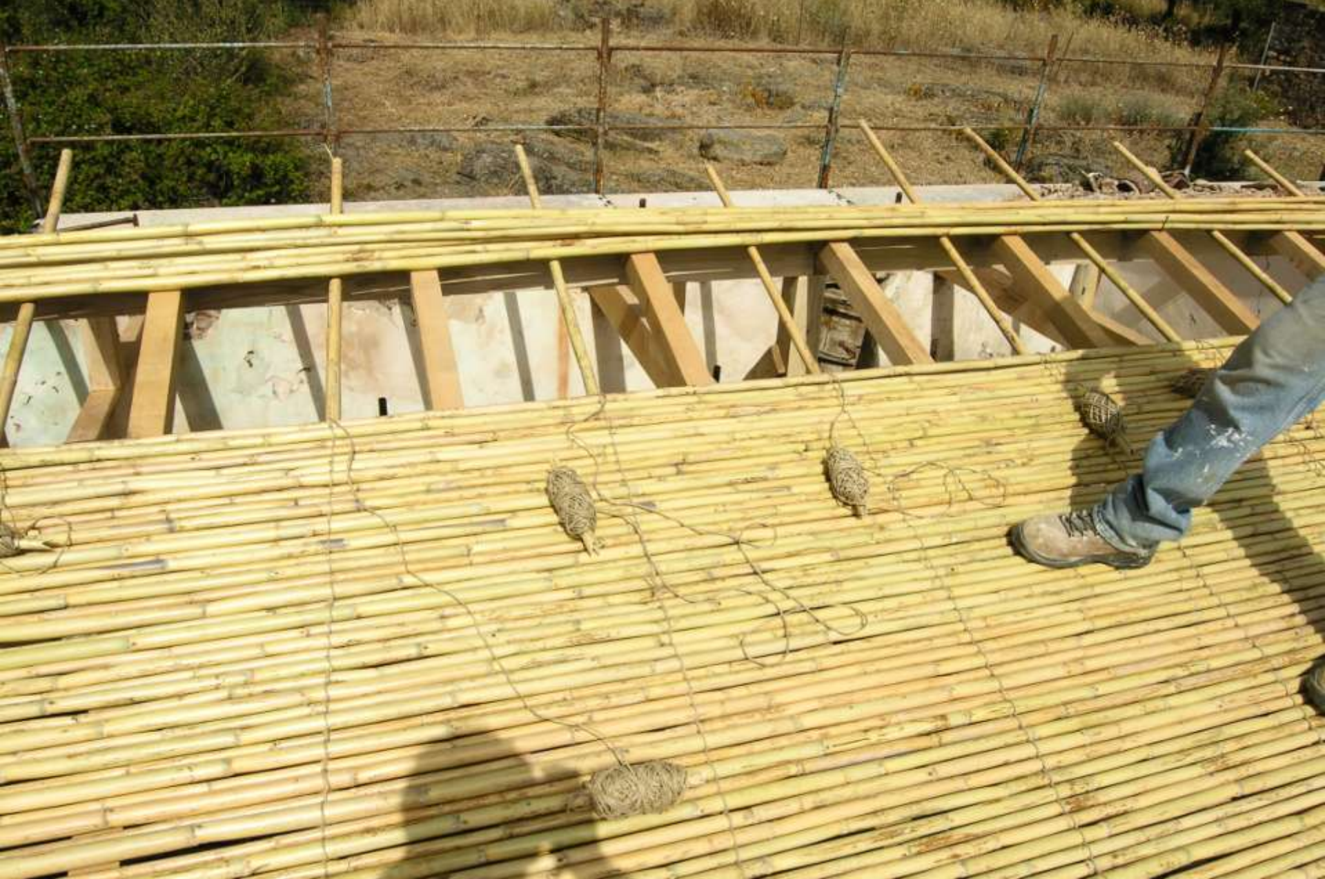
Messa in opera della stuoia in canne di palude.
