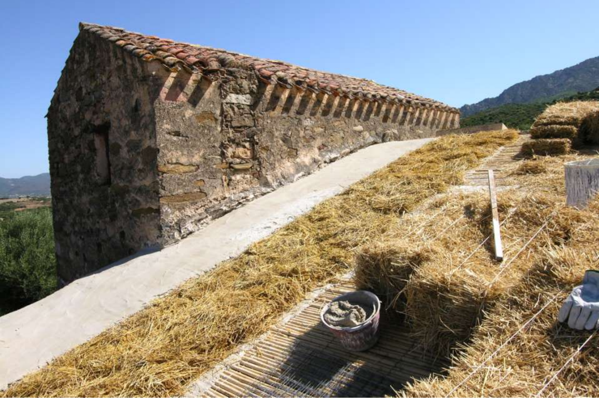
Messa in opera dell'isolamento in paglia.
