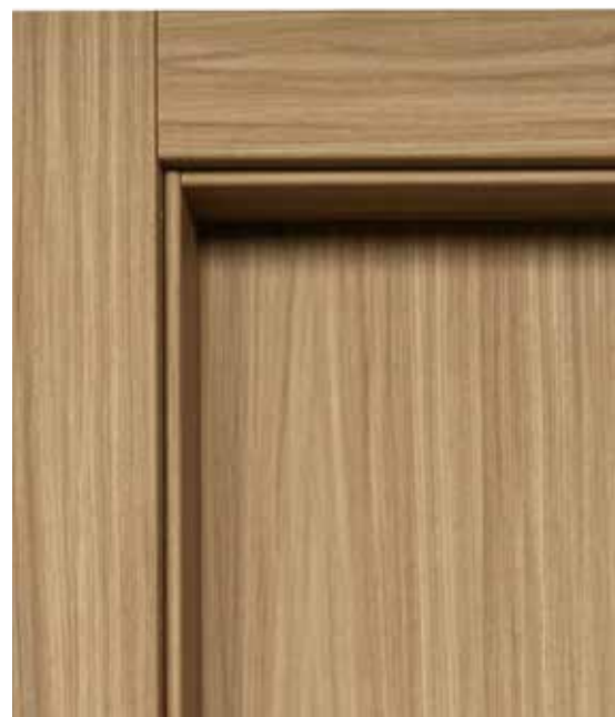
Dettaglio coprifilo / Architrave detail
