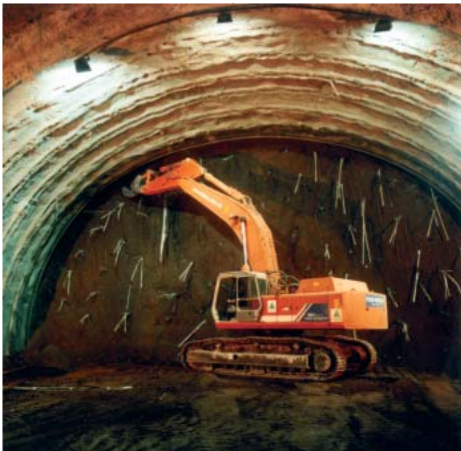
Escavatore in fase di avanzamento in galleria
