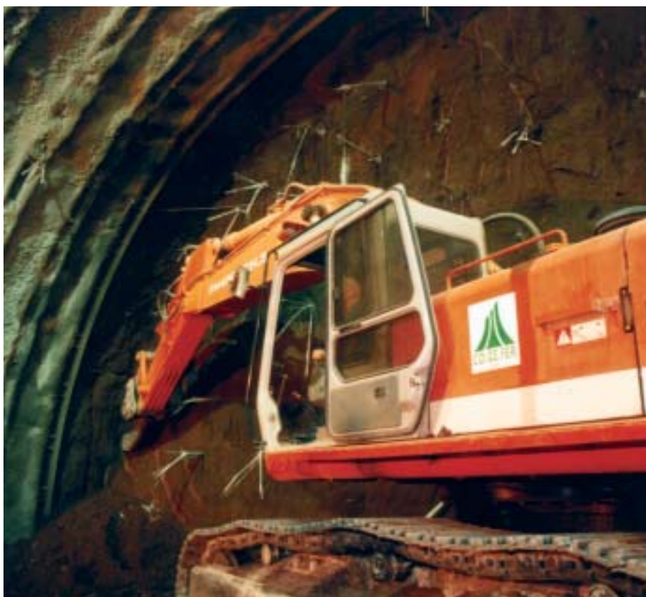
Fase di avanzamento scavo
