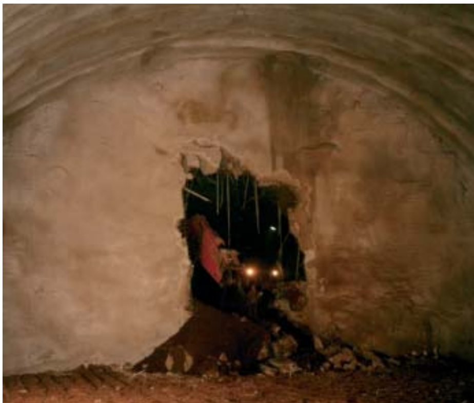
Fase di abbattimento del diaframma con escavatore
