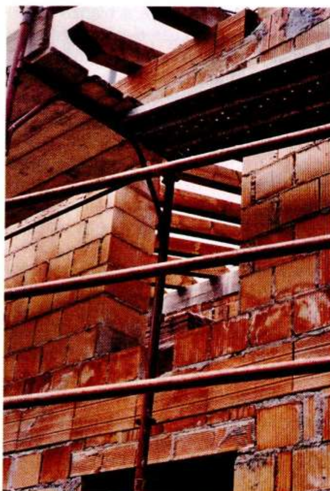
Fig. 8 - Dettaglio della muratura.
