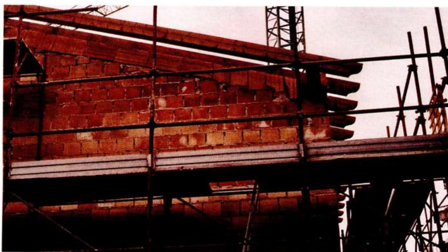
Fig. 9 - Dettaglio della connessione tra muratura e copertura in legno.
