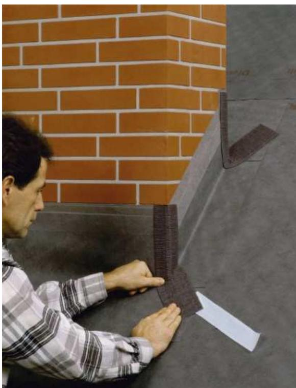
*Una volta effettuato il taglio a "X" della membrana in corrispondenza dell'elemento di sbocco, asportare, se necessario, la parte eccedente e procedere con la sigillatura della membrana alle pareti del punto di discontinuità utilizzando il nastro Flexiroll.*
