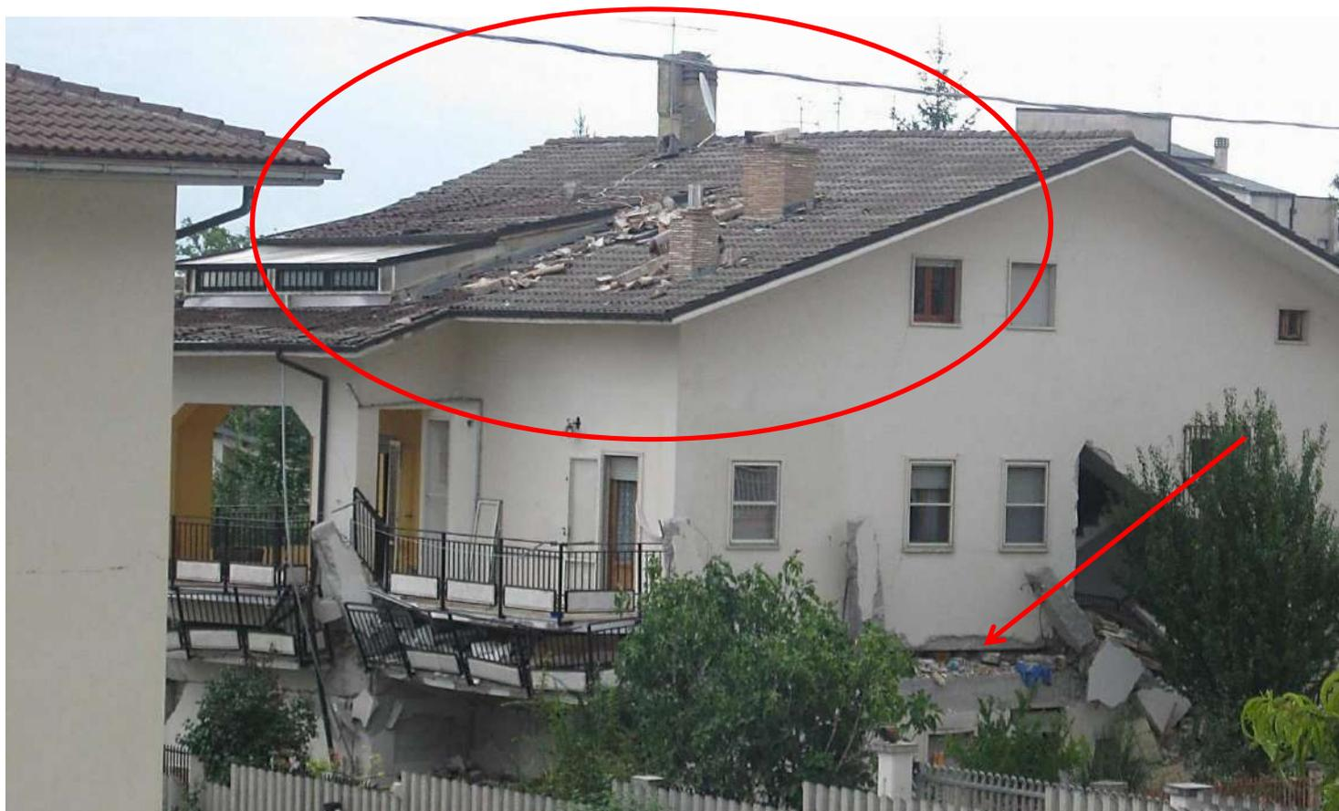
Vista sul retro - edificio con collasso strutturale e manto di copertura in sede, L'Aquila - Italia 2009
