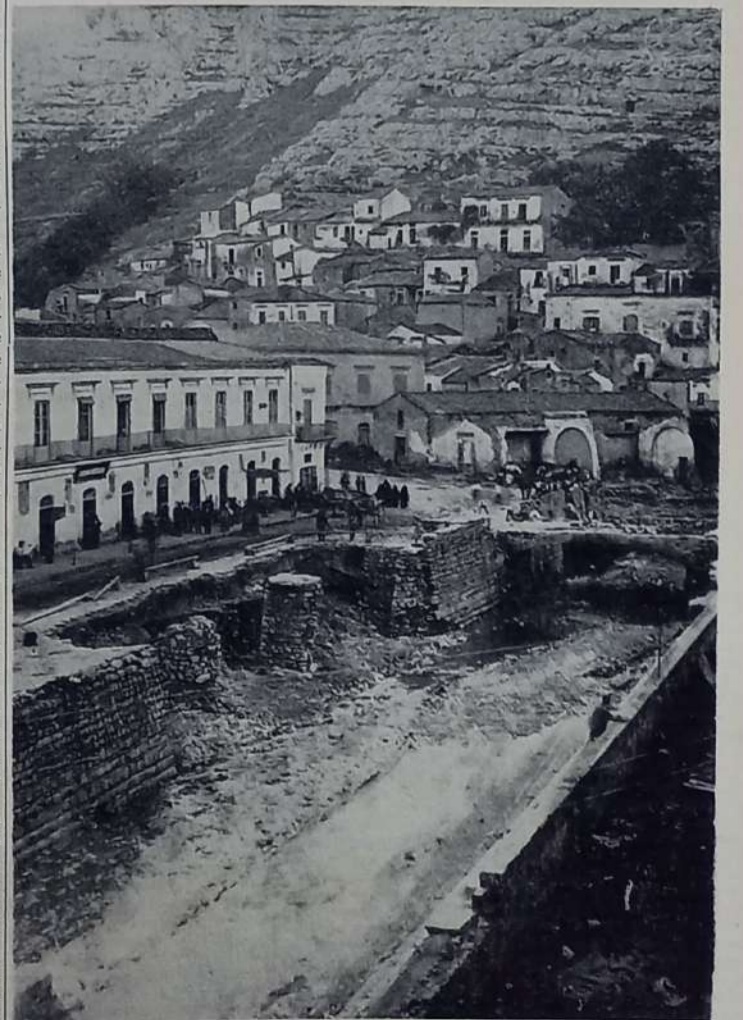
L'alveo compreso tra la via Stretto vecchia e Stretto nuova, così come venne ridotto dalle acque, al loro incontro con il torrente Santa Liberante. In fondo le macerie dei grandi magazzini completamente distrutti. Le fotografie furono effettuate dal modicano Risino.
