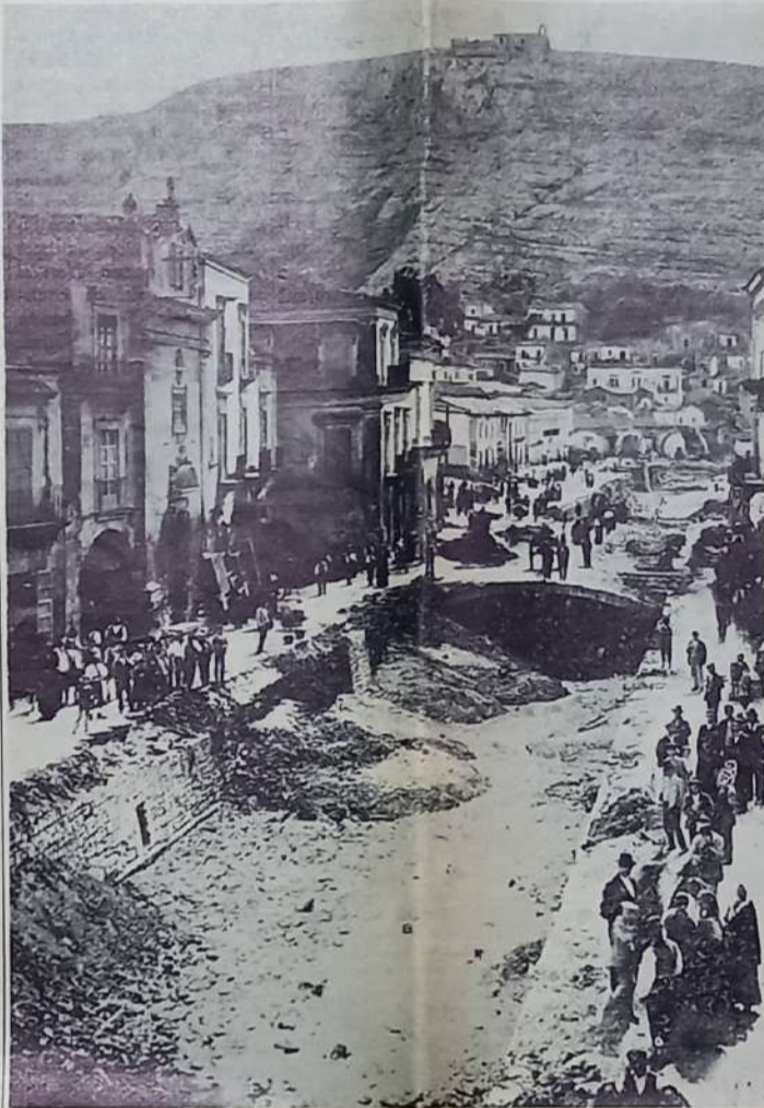
Il materiale che si vede depositato nell'alveo, non è, come si potrebbe credere, l'ammasso di detriti lasciato dall'alluvione, bensì il fango che i soldati e carabinieri e popolani lavorano dalle case di via Santa che dal giorno dell'alluvione venne ricordato come Via Maledetta. Fuori, appoggiati alla parete, i mobili sono stesi ad asciugare.
