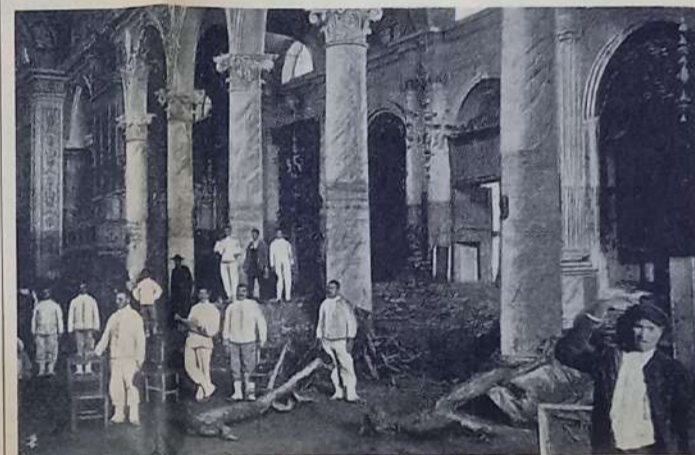
Interno di Santa Maria - Anonimo - La superficie interna della Chiesa di Santa Maria si aggira sui mille metri quadrati. L'acqua fangosa segnò le sue tracce sulle pareti e sulle colonne, a circa tre metri e mezzo dal pavimento, denunziando un volume di ben 3.500 metri cubi. Il fango lasciato dalla piena superava le mille tonnellate, per cui occorsero più di duemila viaggi di carro, per sgomberare la Chiesa.
