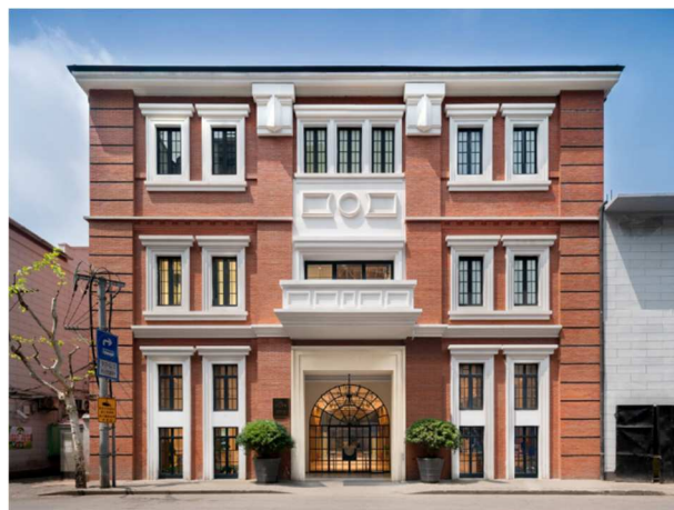
La sede di Shanghai della Galleria Almine Rech
