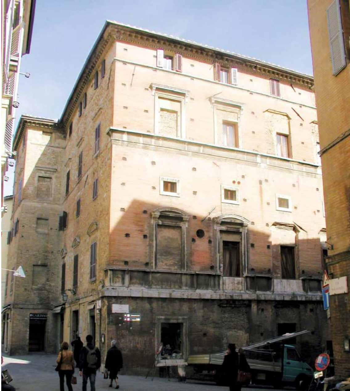
Siena, incompiuto prospetto meridionale di Palazzo Francesconi. Particolare dell'edicola del piano nobile prossima all'angolo, dove, sulla fascia marca piano, si sorgono le basi della coppia di paraste del progetto peruzziano (sotto a destra). Particolare del cornicione (sotto a sinistra).
