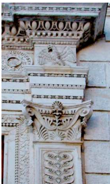
Fig. 13, 14 - Urbino. Palazzo Ducale. Dettaglio con motivi all'antica di uno dei portali della facciata principale (sopra). Dettaglio del capitello e della trabeazione di un portale della facciata principale (a sinistra).
