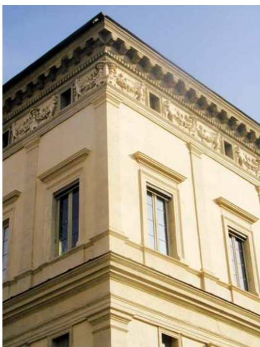
La Farnesina, particolare della soluzione d'angolo con l'elaborato fregio della cornice (a sinistra); dettaglio del portale con la cornice a stucco a finto marmo (sopra).
