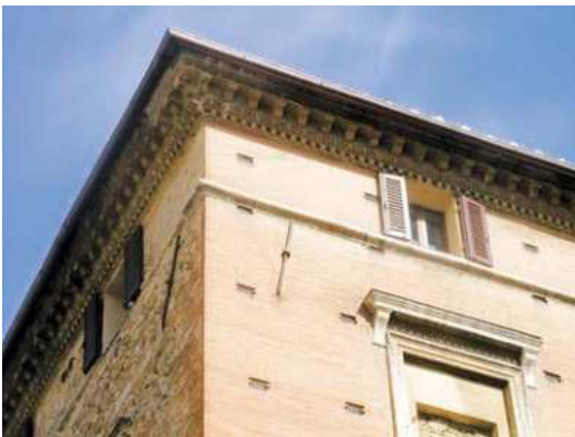
Siena, incompiuto prospetto meridionale di Palazzo Francesconi. Particolare dell'edicola del piano nobile prossima all'angolo, dove, sulla fascia marca piano, si sorgono le basi della coppia di paraste del progetto peruzziano (sotto a destra). Particolare del cornicione (sotto a sinistra).
