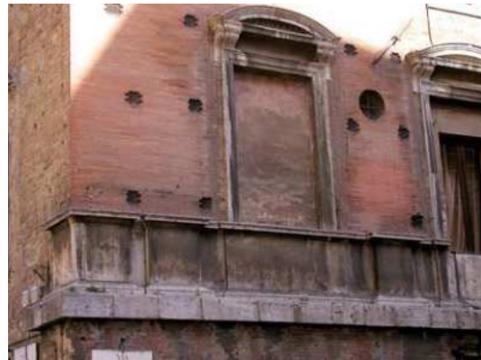
Siena, incompiuto prospetto meridionale di Palazzo Francesconi. Particolare dell'edicola del piano nobile prossima all'angolo, dove, sulla fascia marca piano, si sorgono le basi della coppia di paraste del progetto peruzziano (sotto a destra). Particolare del cornicione (sotto a sinistra).
