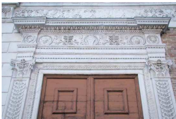
Fig. 13, 14 - Urbino. Palazzo Ducale. Dettaglio con motivi all'antica di uno dei portali della facciata principale (sopra). Dettaglio del capitello e della trabeazione di un portale della facciata principale (a sinistra).
