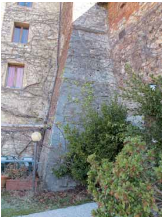
Frosini, particolare del contrafforte a scarpa del torrione del castello.
