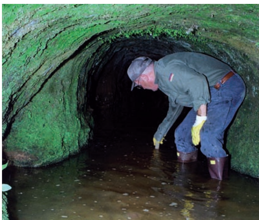
La terminazione del canale realizzata in blocchi di pietra a secco (sopra in alto).
