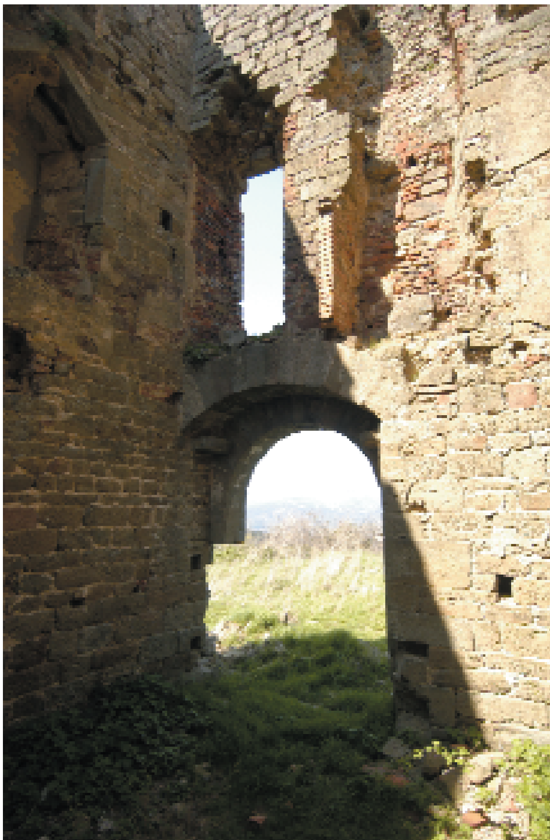
Fig. 8 Uno dei due ingressi al monastero, quello che si apre sulla parete occidentale dell'ala meglio conservata. In origine era a destra della facciata della chiesa. Si notino le tracce delle successive trasformazioni dello spazio (solai, tramezzi, aperture, camini).
