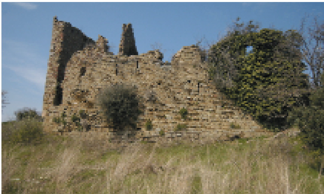
Fig. 9 La facciata orientale dell'abbazia come appare oggi, con le tracce delle finestre a bifora e le numerose feritoie a difesa del fronte più esposto.
