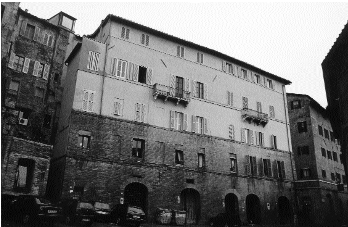
3 – Siena, piazza Bargagli Petrucci già Prato della Stufasecca. Facciata posteriore della locanda del Sole.
