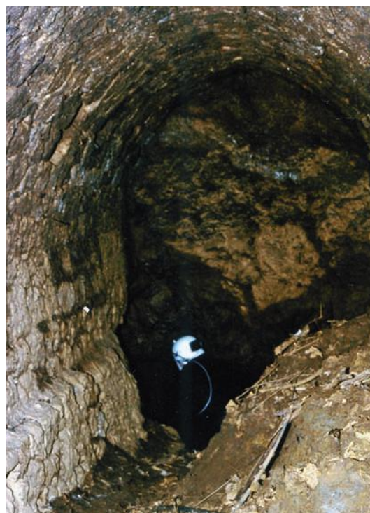
Fig. 21 Inghiottitoio del Mulinaccio: la fine del tratto artificiale e l'inizio della cavità naturale.
