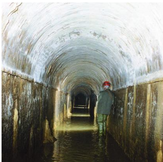
Figg. 11-12 Alcuni tratti della galleria che mostrano l'incamiciatura continua delle pareti e il pavimento lastricato.
