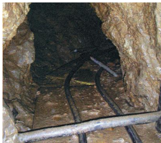
Fig. 22 Il Mulinaccio attrezzato con un binario per lo scorrimento del carrello di trasporto dei detriti durante l'ultimo scavo.
