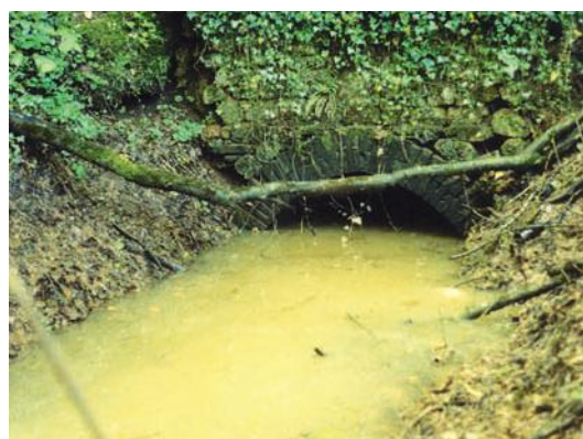
Fig. 23 L'inghiottitoio del Mulinaccio assolve ancora il deflusso parziale nei periodi piovosi.
