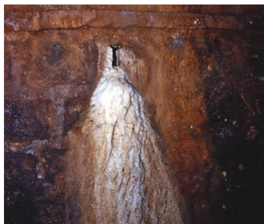
Fig. 14 In alcuni tratti della galleria le percolazioni di drenaggio hanno formato colonnette concrezionate.
