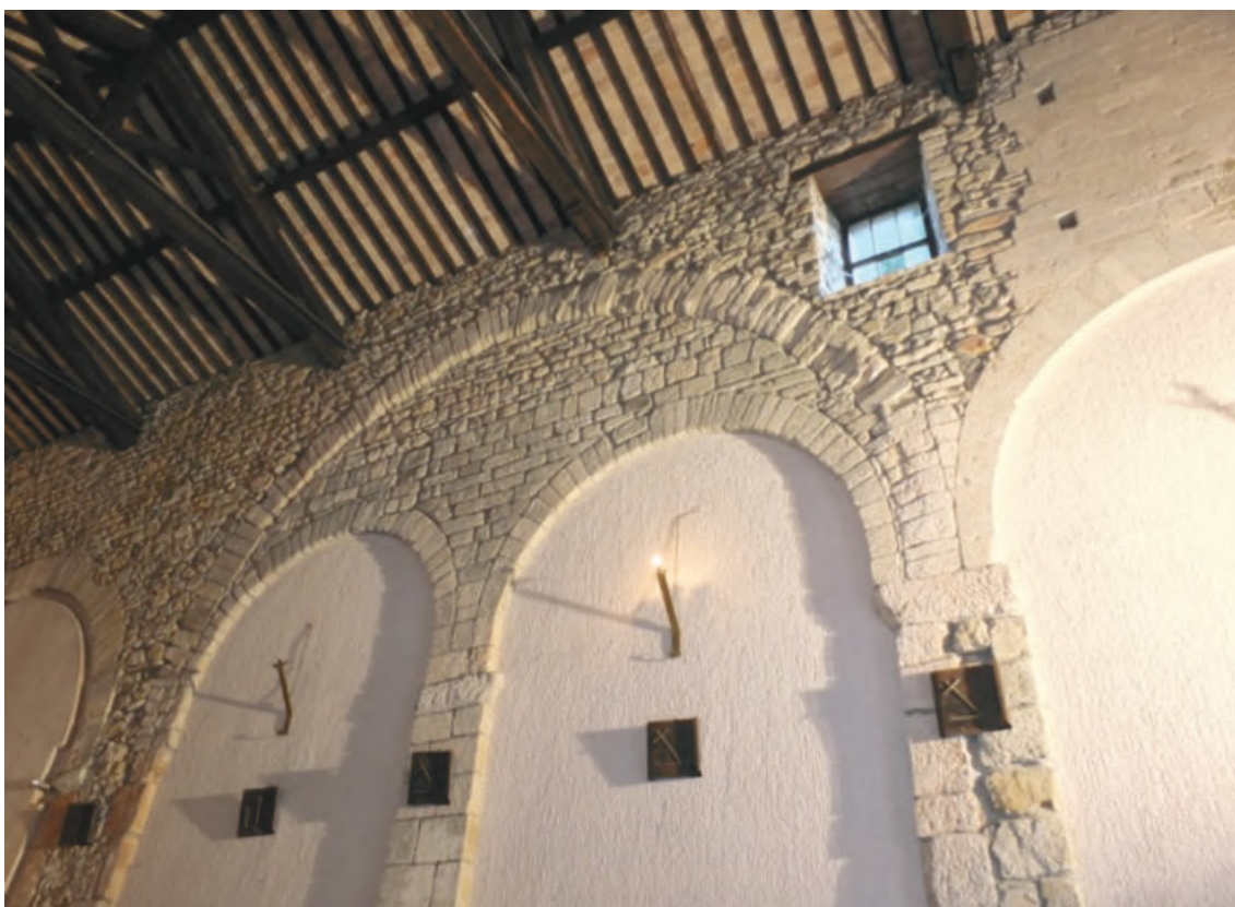
Parete interna destra con le tamponature delle 4 arcate (si noti che la prima arcata con la muratura sovrastante sono dello stesso accurato tipo di pietra della facciata, ma si appoggiano al primitivo pilastro)
