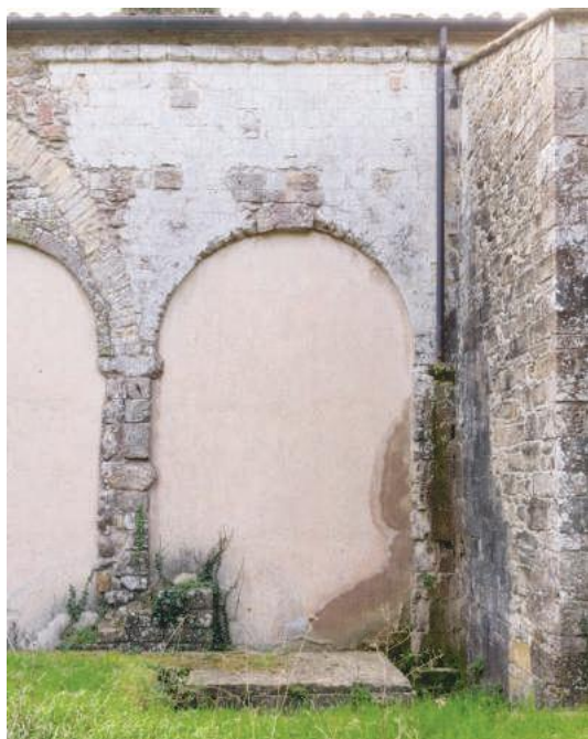
Controfacciata della navatella sinistra e tamponatura della prima arcata divisoria (si noti che l'arco e la muratura sovrastante, poggiando sul primitivo pilastro, presentano lo stesso accurato tipo di pietra della facciata)
