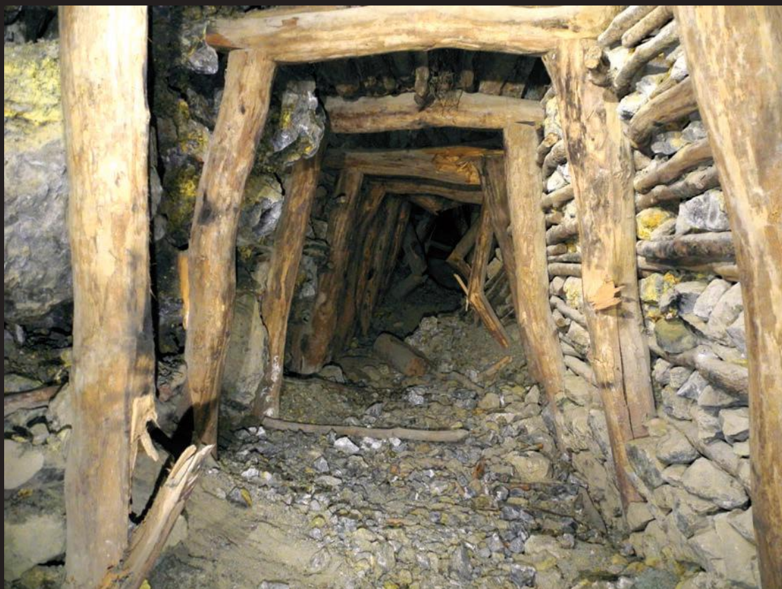
Miniera delle Cetine - Galleria "armata" verso il pozzo Crida
