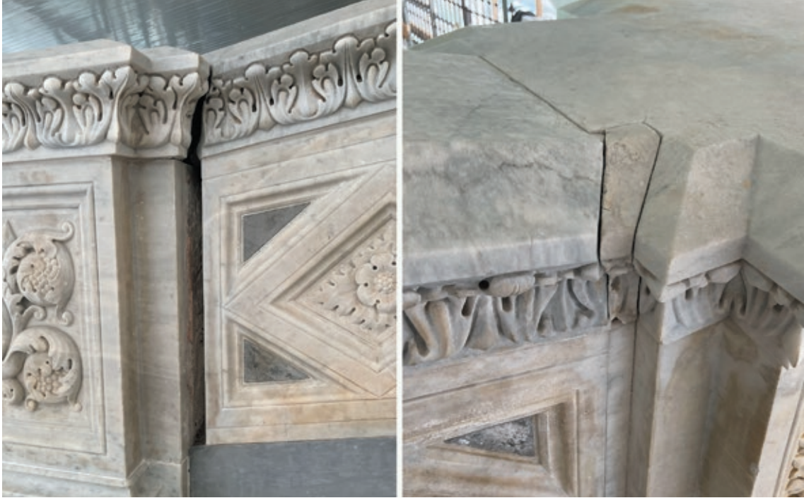
8. Dettagli dei tasselli e listelli posizionati per riordinare il contatto dei due pilastri di testa ai parapetti.
