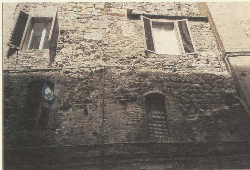
Frammenti di cortina altomedievale in una casa di via T. Pendola (non casualmente già chiamata delle Murelle ), riferibile ad una delle più antiche sezioni delle mura urbane.
