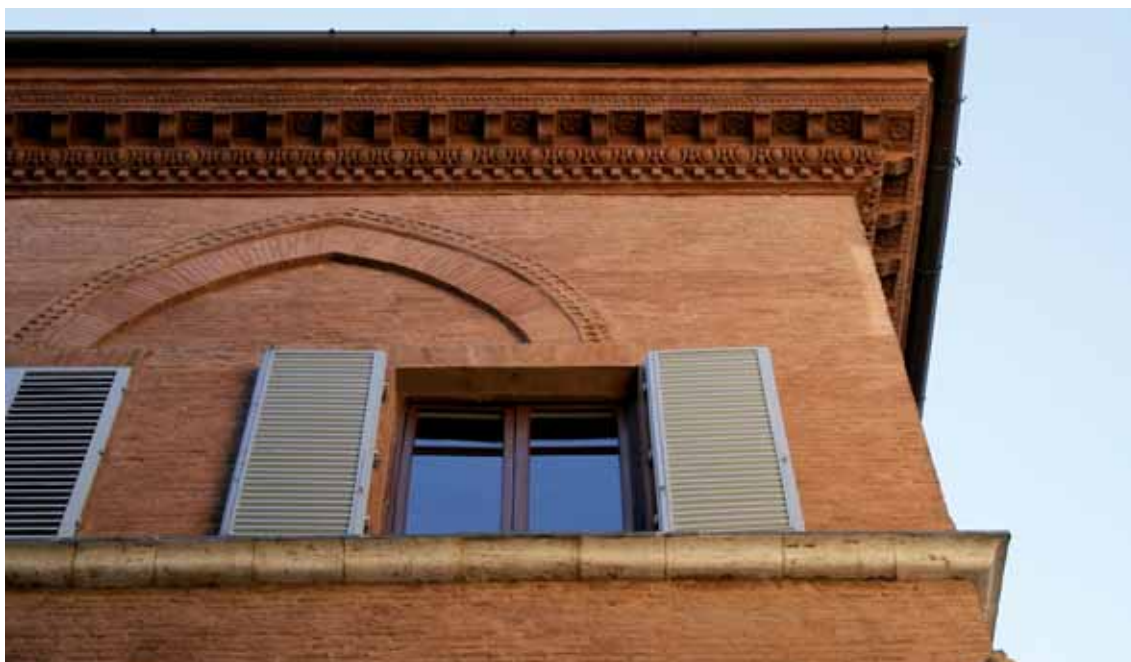
fig. 18 - Palazzo Malavolti, particolare
