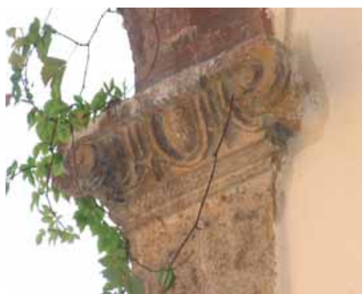
Fig. 8 Particolare del capitello ionico della parasta del loggiato al secondo piano.
