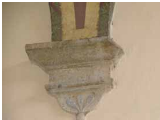
Fig. 7 Particolare del peduccio del medesimo loggiato al piano nobile.
