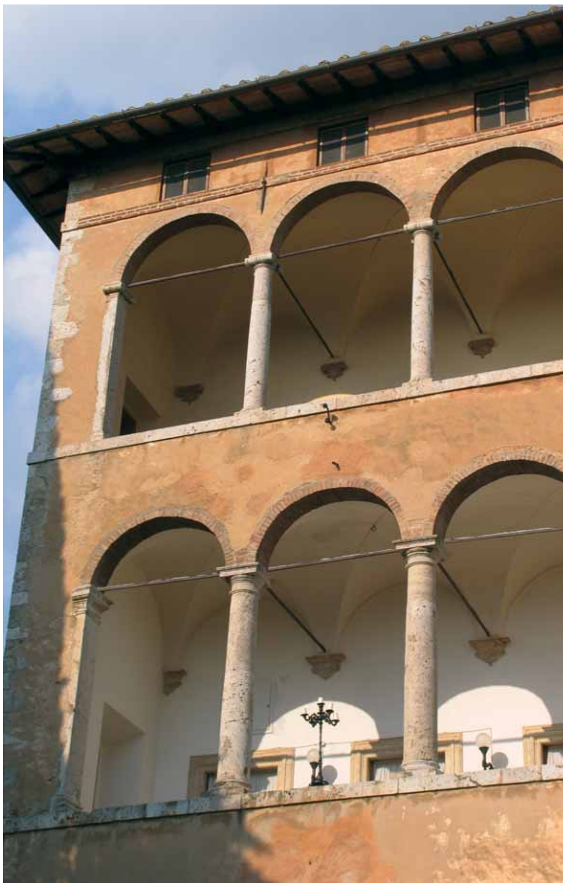
Fig. 10 Particolare del loggiato (piano nobile e piano secondo) del fronte verso il giardino all'italiana della villa.
