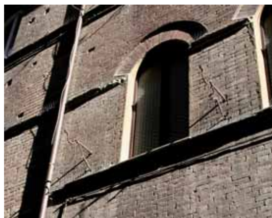
fig. 2 - Palazzo in via Sallustio Bandini, 5-9, particolari
