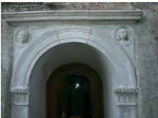
Fig. 6 Particolare del portale ionico più antico presente nella villa (posto sul fronte sinistro, rispetto la facciata principale della villa).
