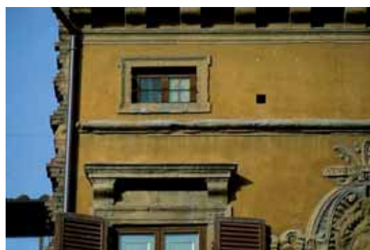
fig. 11 - Palazzo Palmieri, particolare
