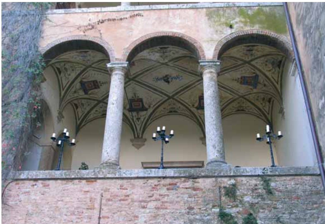
Fig. 3 Loggiato del piano nobile della facciata principale.
