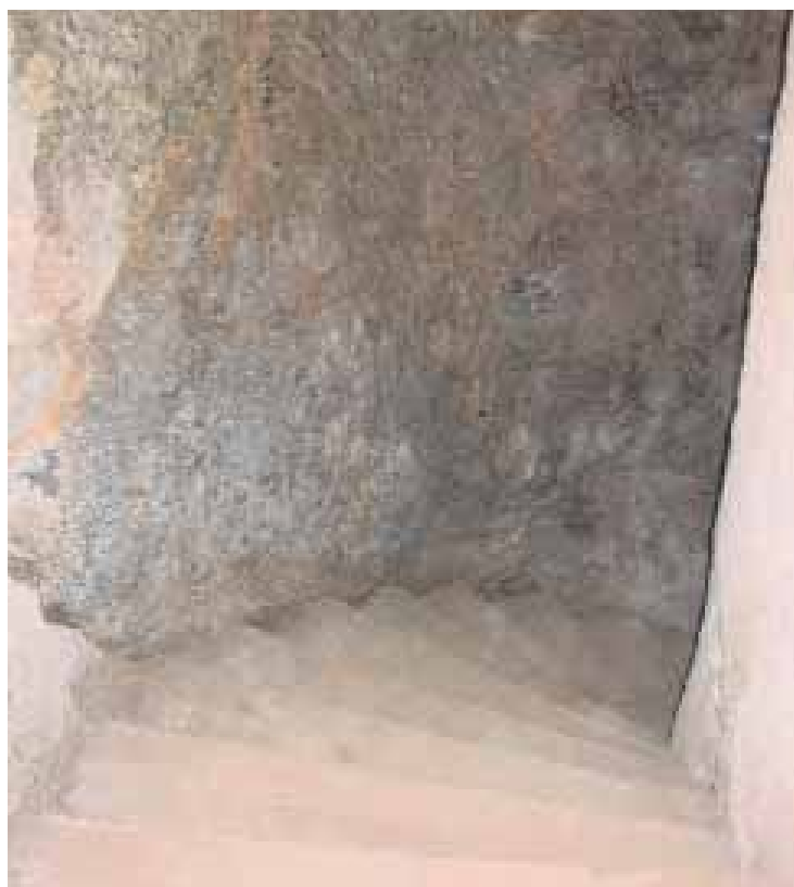
Fig. 11 Sotterranei. Rampa che prosegue la discesa dopo l'ambiente circolare della cisterna. Si osservi come da questo punto cambia la muratura, ma anche, per quanto concerne le altezze, la copertura a botte e i gradini: le mura non sono più costruite ma scavate nella roccia come si può notare dai solchi lasciati dagli utensili.
