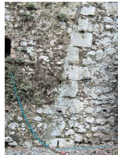
Fig. 15 Prospetto rivolto a nord: si osservi sul muro la traccia di un precedente bastione rinascimentale costituita da conci di pietra disposti a scarpa ed in obliquo.
