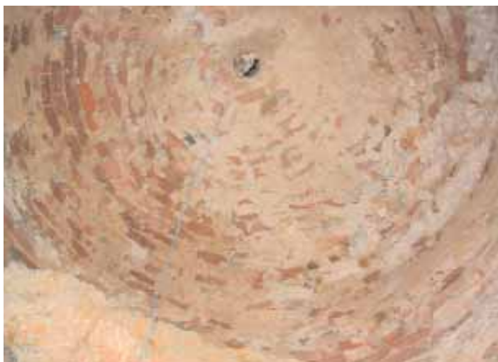
Fig. 12 Sotterranei. Ambiente circolare coperto a cupola con mattoni a ricorsi orizzontali. Un tempo doveva essere una cisterna per l'approvvigionamento dell'acqua vista la connessione diretta ad un altro ambiente (pozzo di troppo pieno) munito di docci all'estremità superiore. Quando il pozzo si riempiva in eccesso veniva in soccorso il pozzo di troppo pieno.
