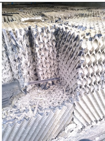
Figura 9: Interventi di demolizione
